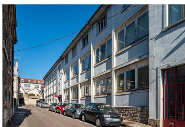
Vue d'ensemble depuis le bas de la rue. Phot. Jérôme Mongreville IVR43_20192500111NUC4A
