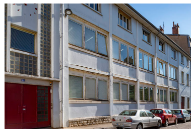
Façade ouest vue de trois quarts gauche. Phot. Jérôme Mongreville IVR43_20192500110NUC4A
