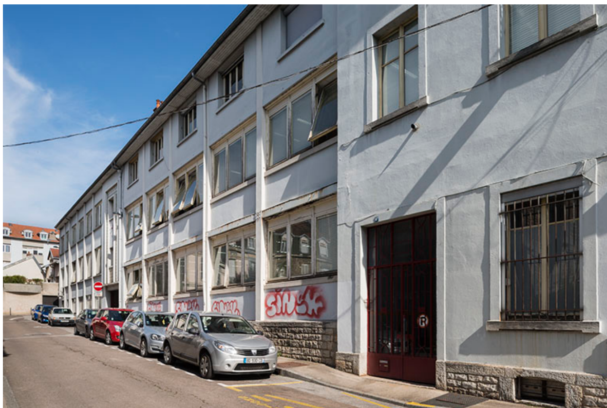
Façade antérieure de l'atelier principal.
