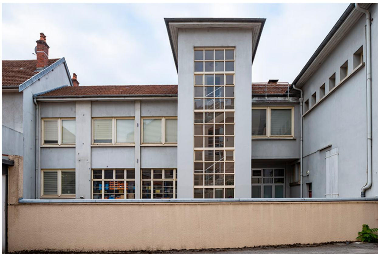
Façade sur cour.
