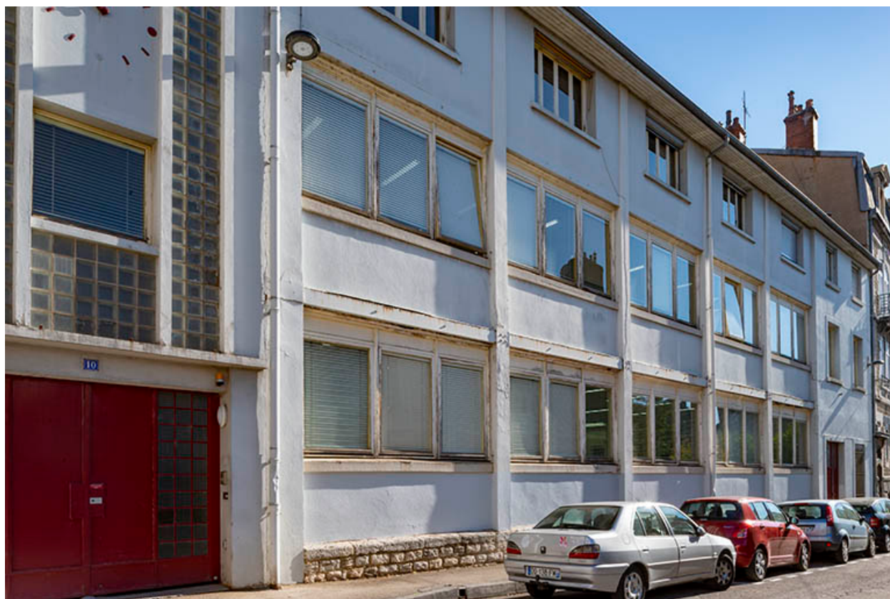
Façade ouest vue de trois quarts gauche.
