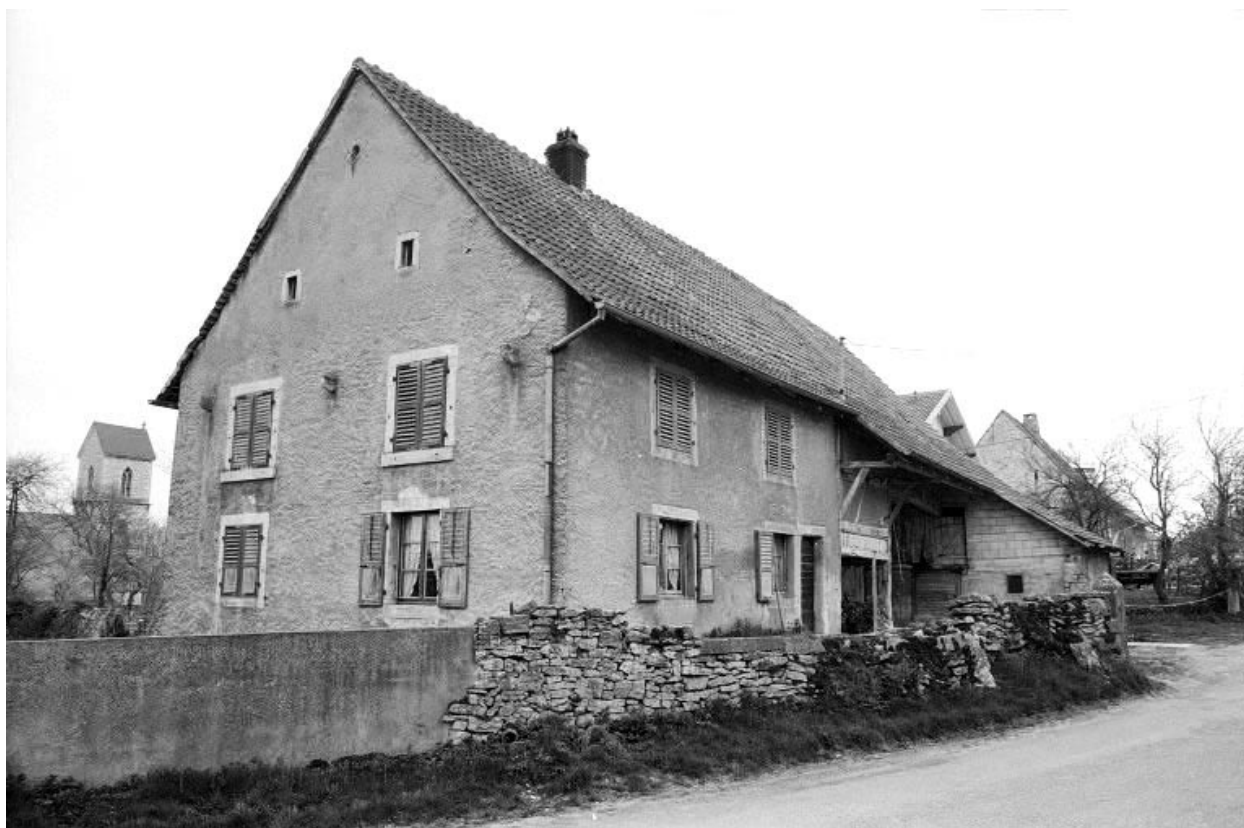
Façades antérieure et latérale gauche.
