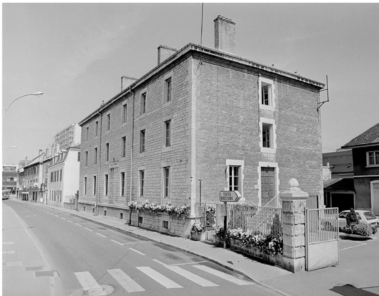
Façade principale et façade latérale droite.
