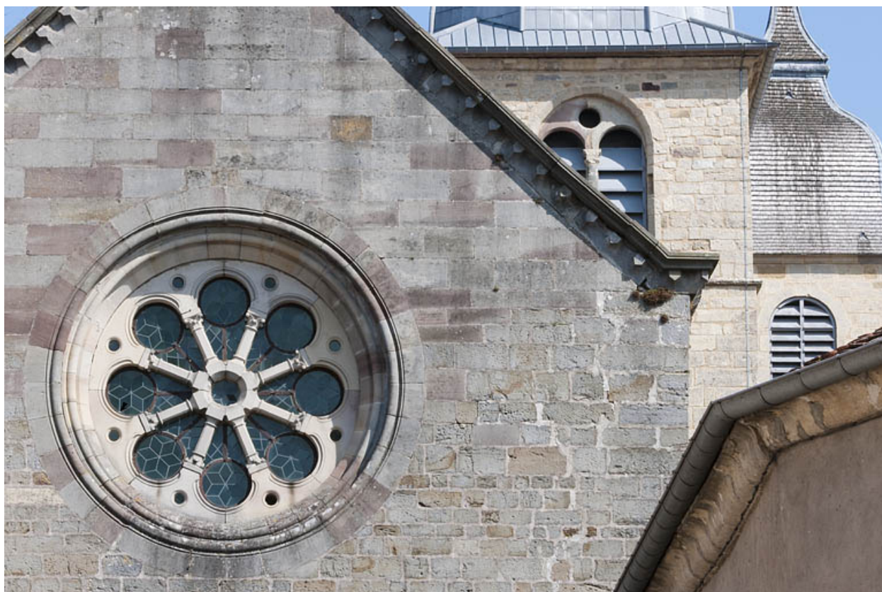
Façade antérieure, détail : l'oculus.
