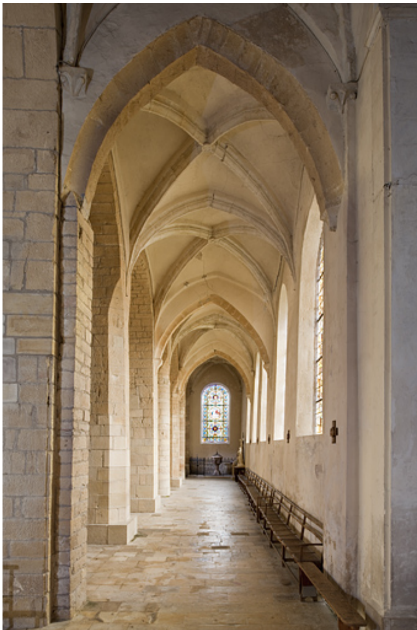
Bas-côté gauche vu depuis le transept.
