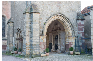
Le porche vu de trois quarts. Phot. Mary Ruffinoni IVR43_20127000274NUC4A
