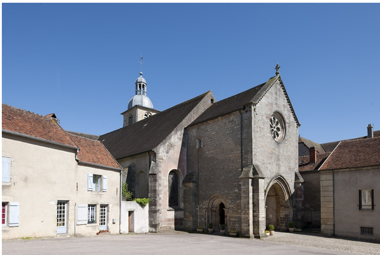
Vue générale depuis la place Sainte-Gude.
