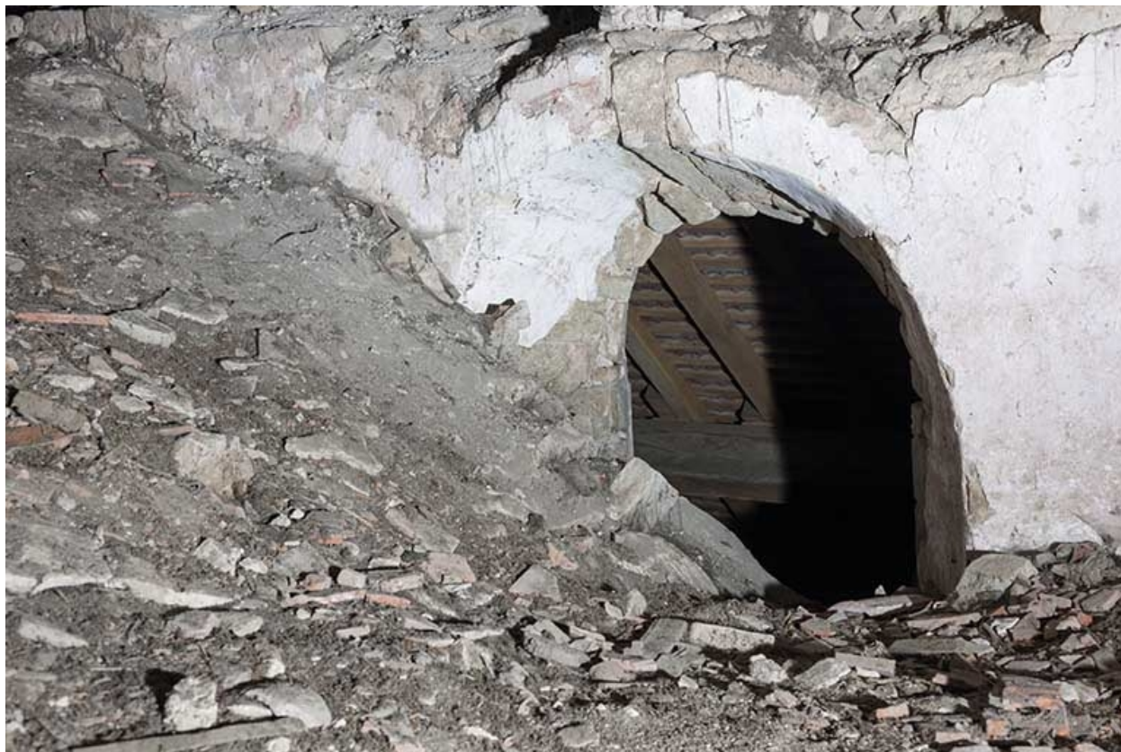
Ancienne baie au-dessus de la voûte.
