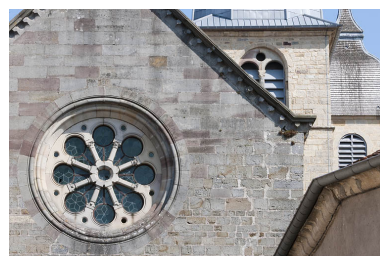
Façade antérieure, détail : l'occulus. Phot. Jérôme Mongreville IVR43_20127000072NUC4A
