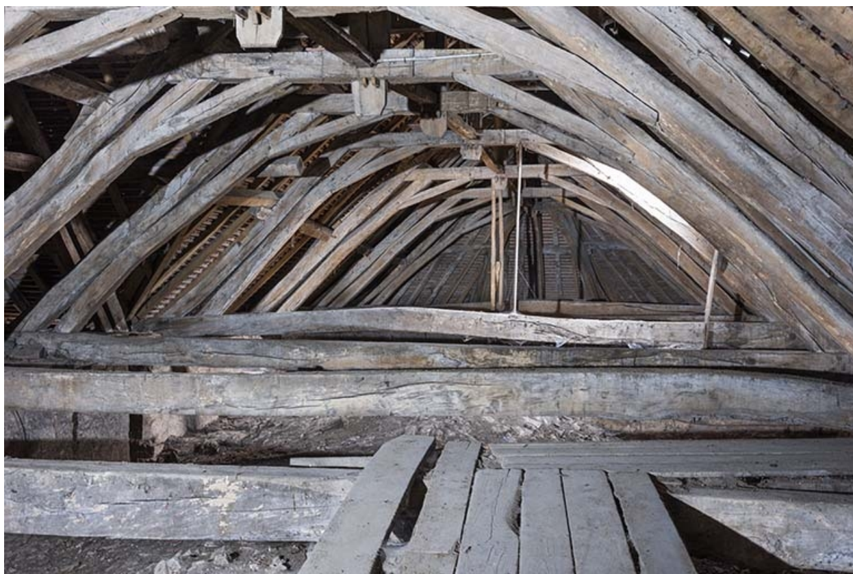
Autre vue de la charpente.
