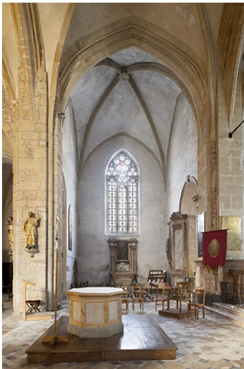
Chapelle du bras nord du transept.
