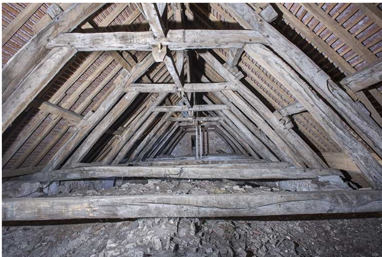
Vue d'ensemble de la charpente.
