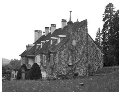
Façade antérieure et face gauche du logis. Phot. Jérôme Mongreville IVR43_19853900171X
