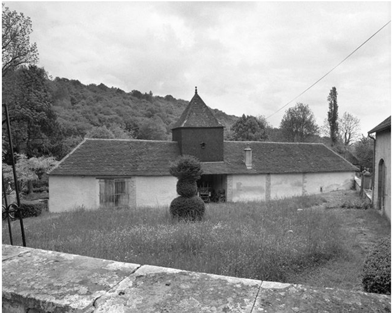
Les communs : façade postérieure.
