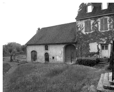
Façade antérieure du logis : partie gauche. Phot. Jérôme Mongreville IVR43_19853900170X
