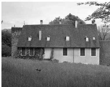
Face postérieure du logis. Phot. Jérôme Mongreville IVR43_19853900172X
