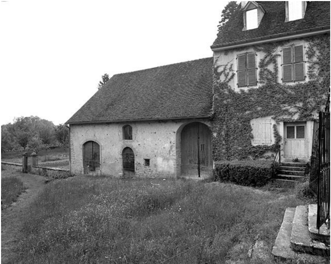
Façade antérieure du logis : partie gauche.
