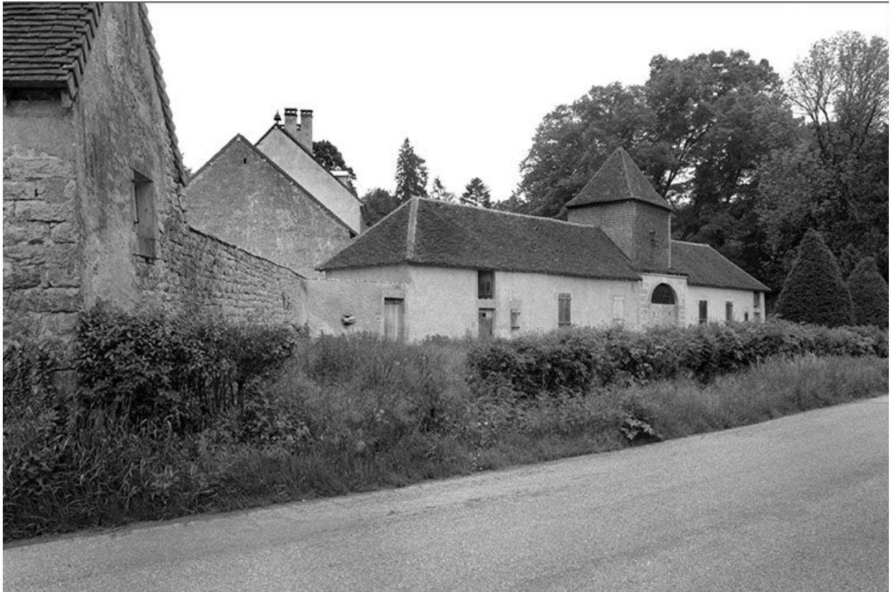
Les communs vus depuis la route.
