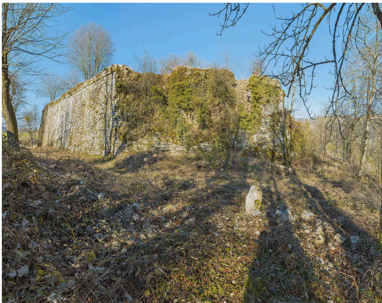
Vue depuis le nord.
