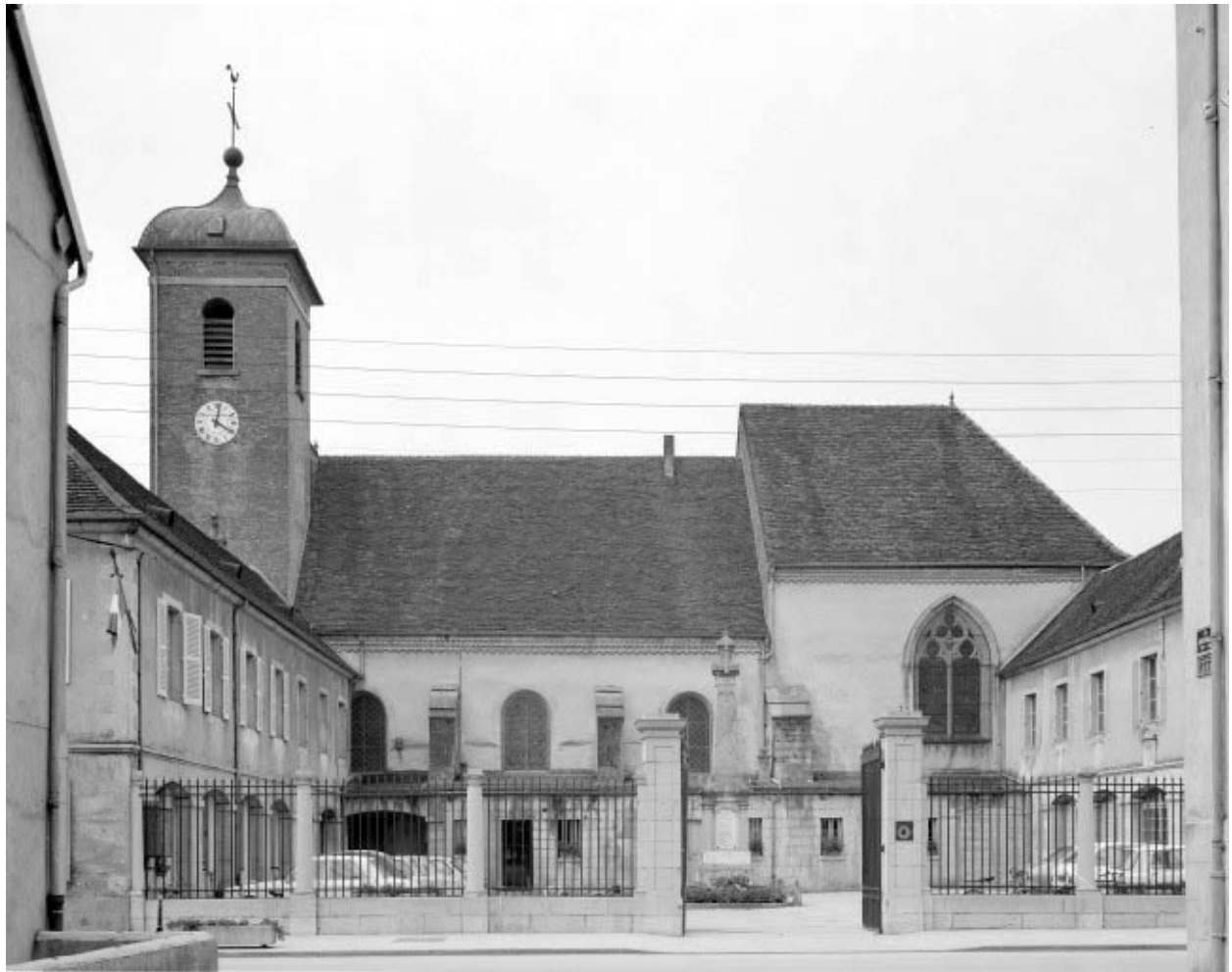
Façade latérale droite.
