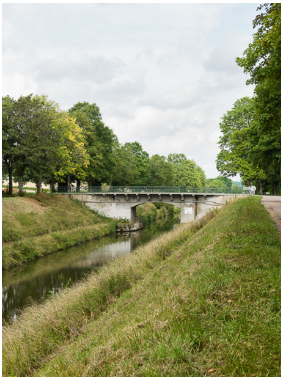
Vue d'ensemble du pont.
