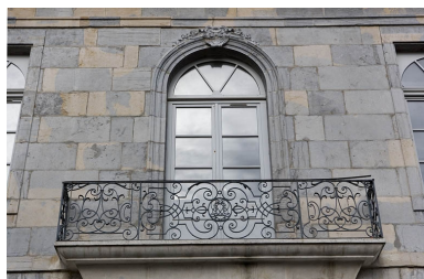
Détail du balcon en fer forgé sur rue. Phot. Yves Sancey IVR43_20072500182NUCA
