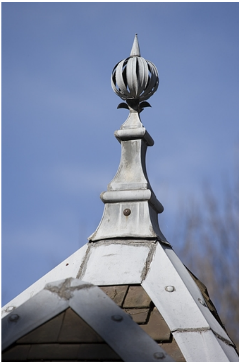
Bâtiment des anciennes écurie et remise : détail d'un épi de faîtage.
