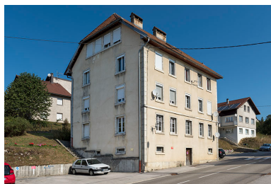
Façades antérieure et latérale gauche.
