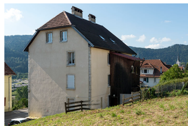
Façades postérieure et latérale droite.
