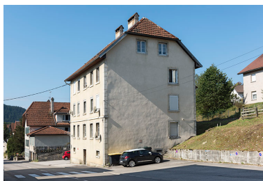
Façades antérieure et latérale droite.
