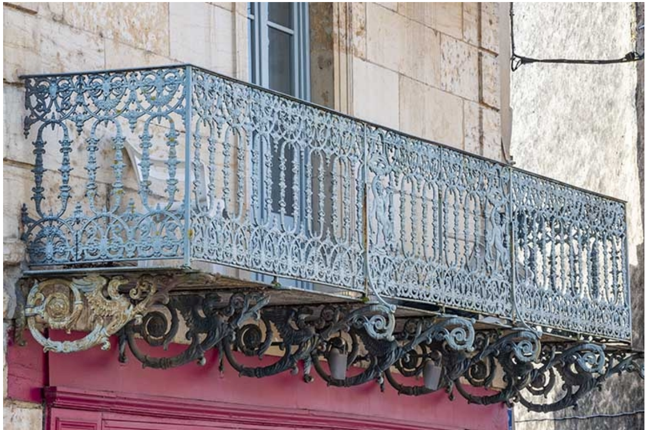
Le balcon du premier étage.
