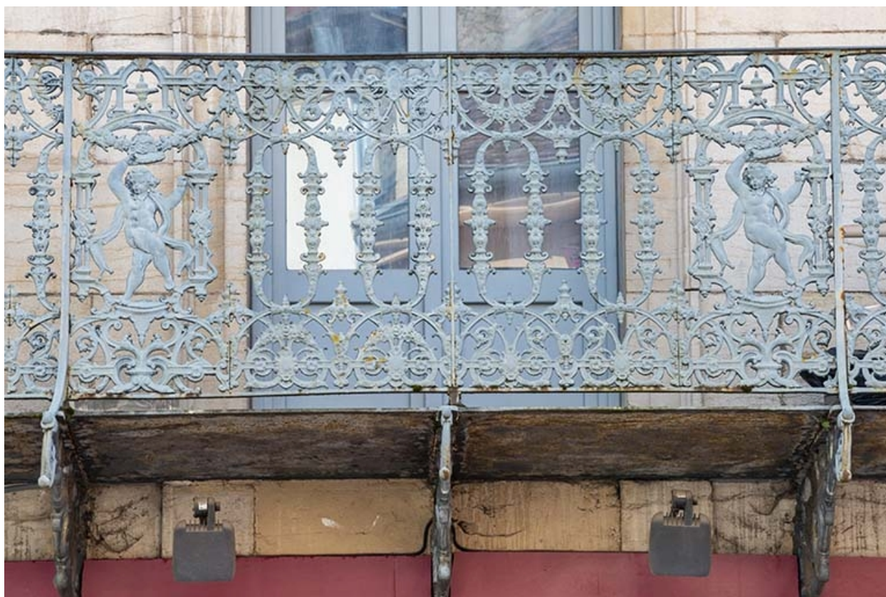
Détail du balcon du premier étage.
