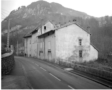
Logement et séchoir à ébauchons. Phot. Jérôme Mongreville IVR43_19913900545X
