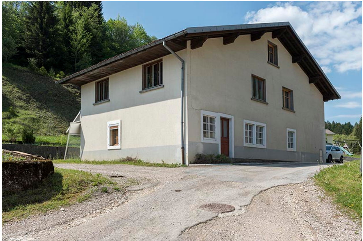
Façades postérieure et latérale gauche.
