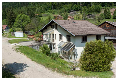
Façades postérieure et latérale gauche.
