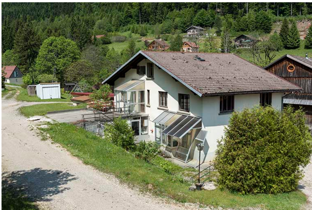
Façades postérieure et latérale gauche.
