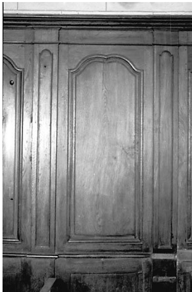
Détail d'un panneau de la nef. Phot. Yves Sancey IVR43_19732500104Z
