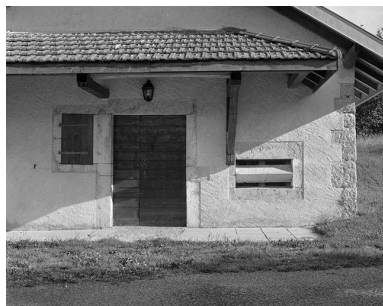
Porte d'entrée et baie fromagère de la fromagerie des Communailles, à Longchaumois.
