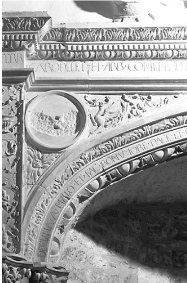
Détail : écoinçon gauche. Phot. Yves Sancey IVR43_19782500828Z
