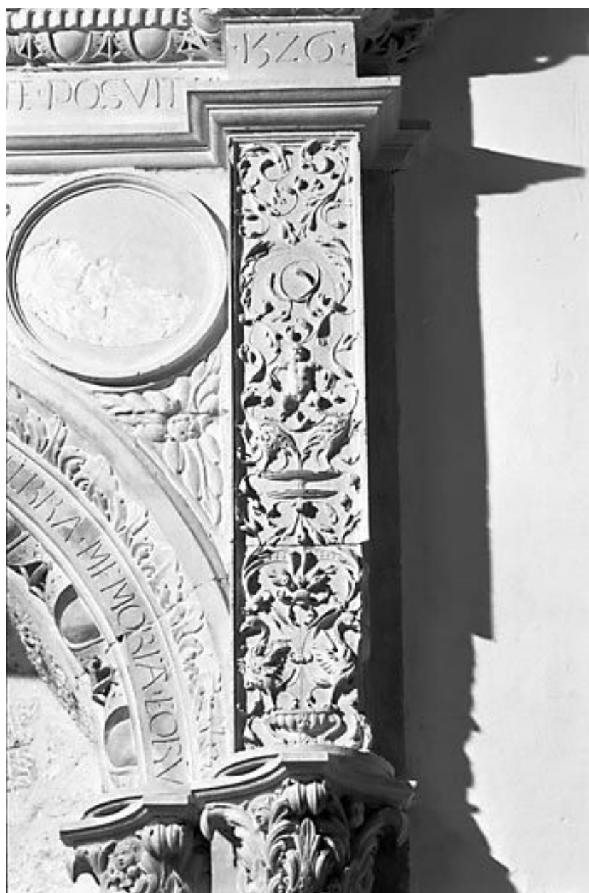
Détail : pilastre et écoinçon droits.
