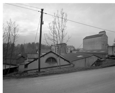
La minoterie vue de l'est. Phot. Jérôme Mongreville IVR43_19963900030V
