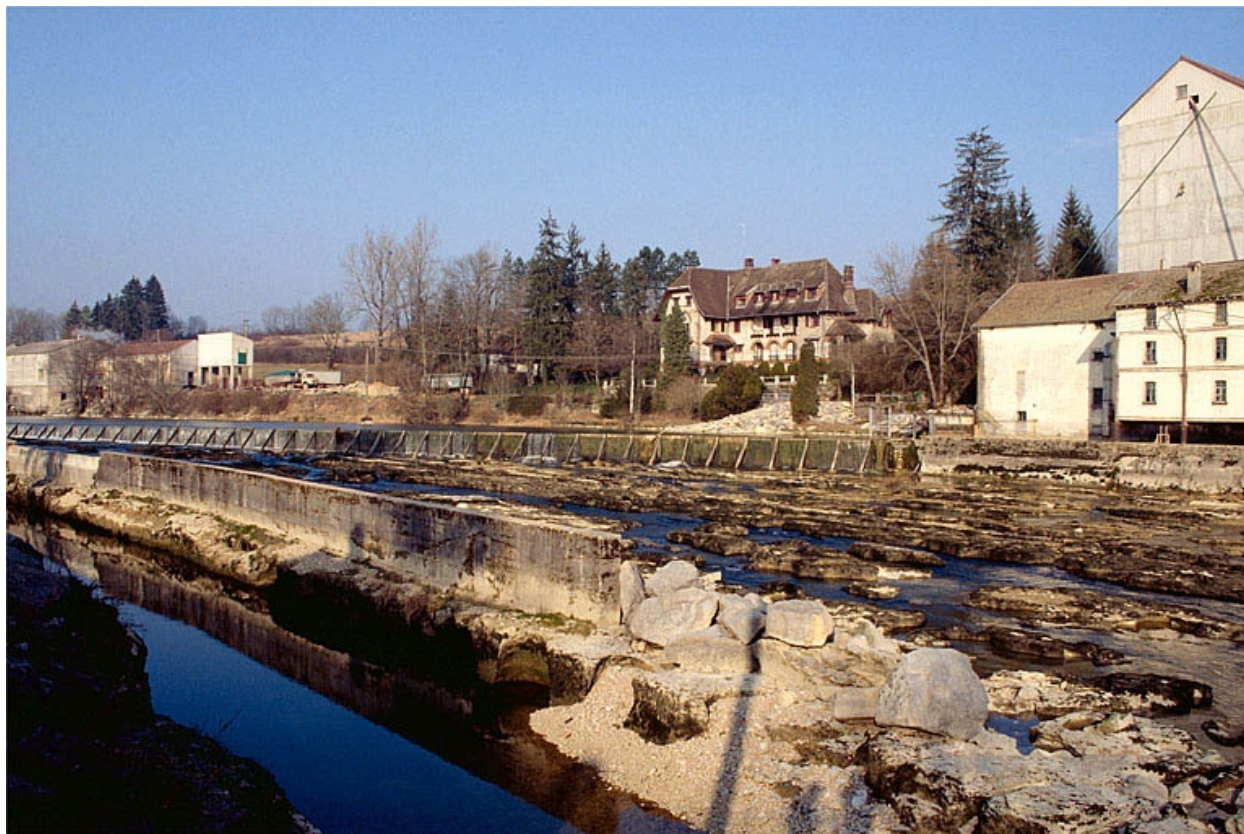
Vue d'ensemble depuis le sud.
