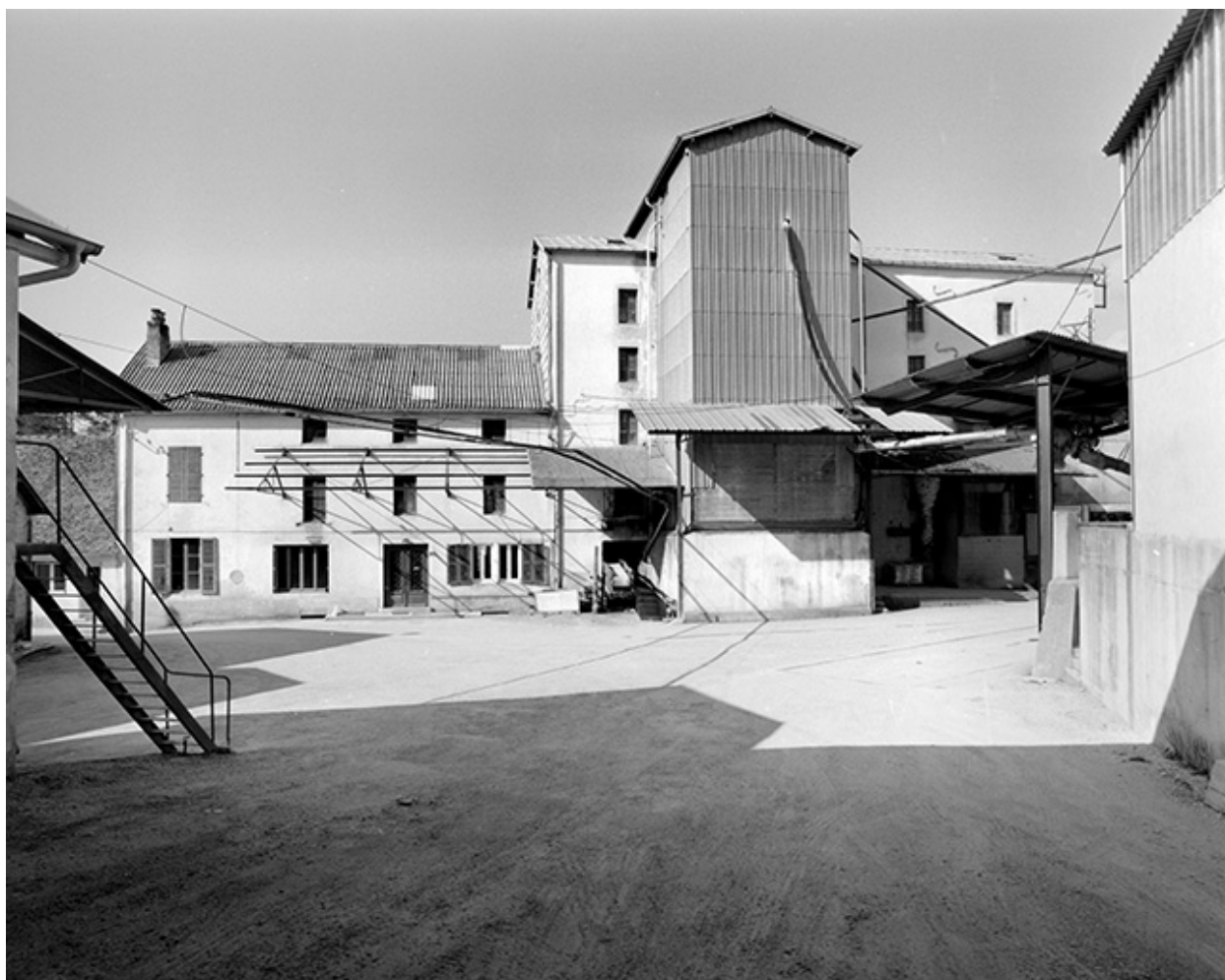
Bureau, atelier de fabrication et silo.
