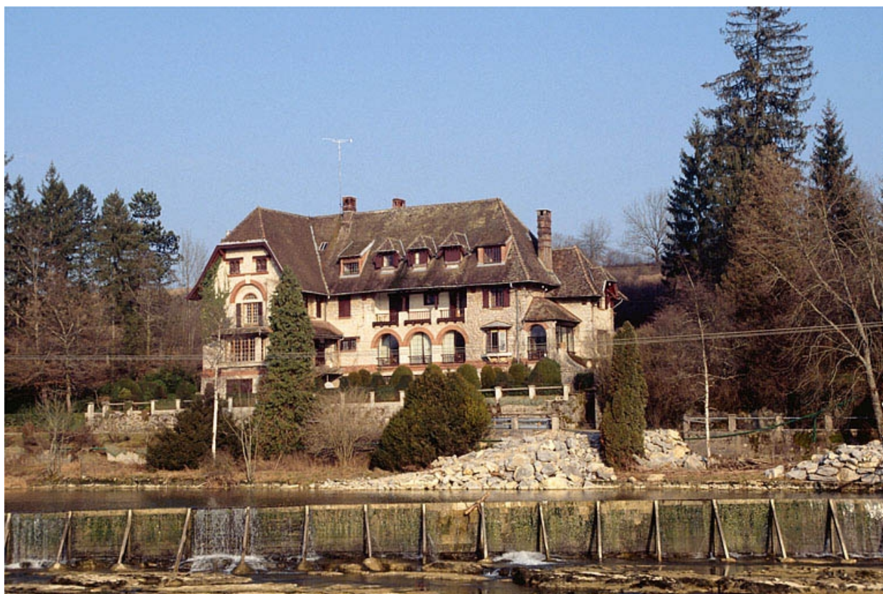
Façade antérieure du logement patronal.
