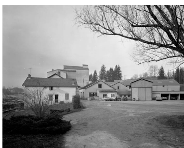
La minoterie vue du sud. De gauche à droite : logement d'ouvriers, atelier de réparation et remises à automobiles. Phot. Jérôme Mongreville IVR43_19963900031V
