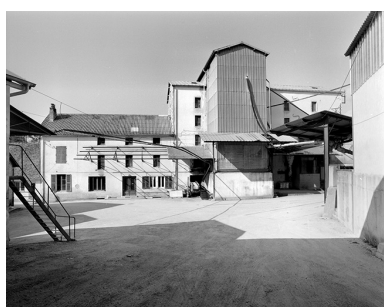
Bureau, atelier de fabrication et silo. Phot. Jérôme Mongreville IVR43_19963900123X
