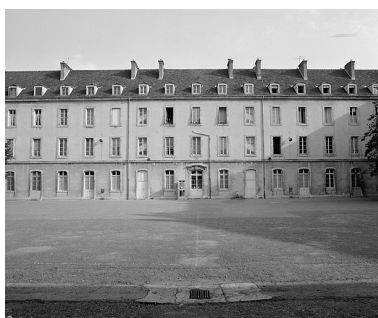
Façade postérieure sur la cour.
