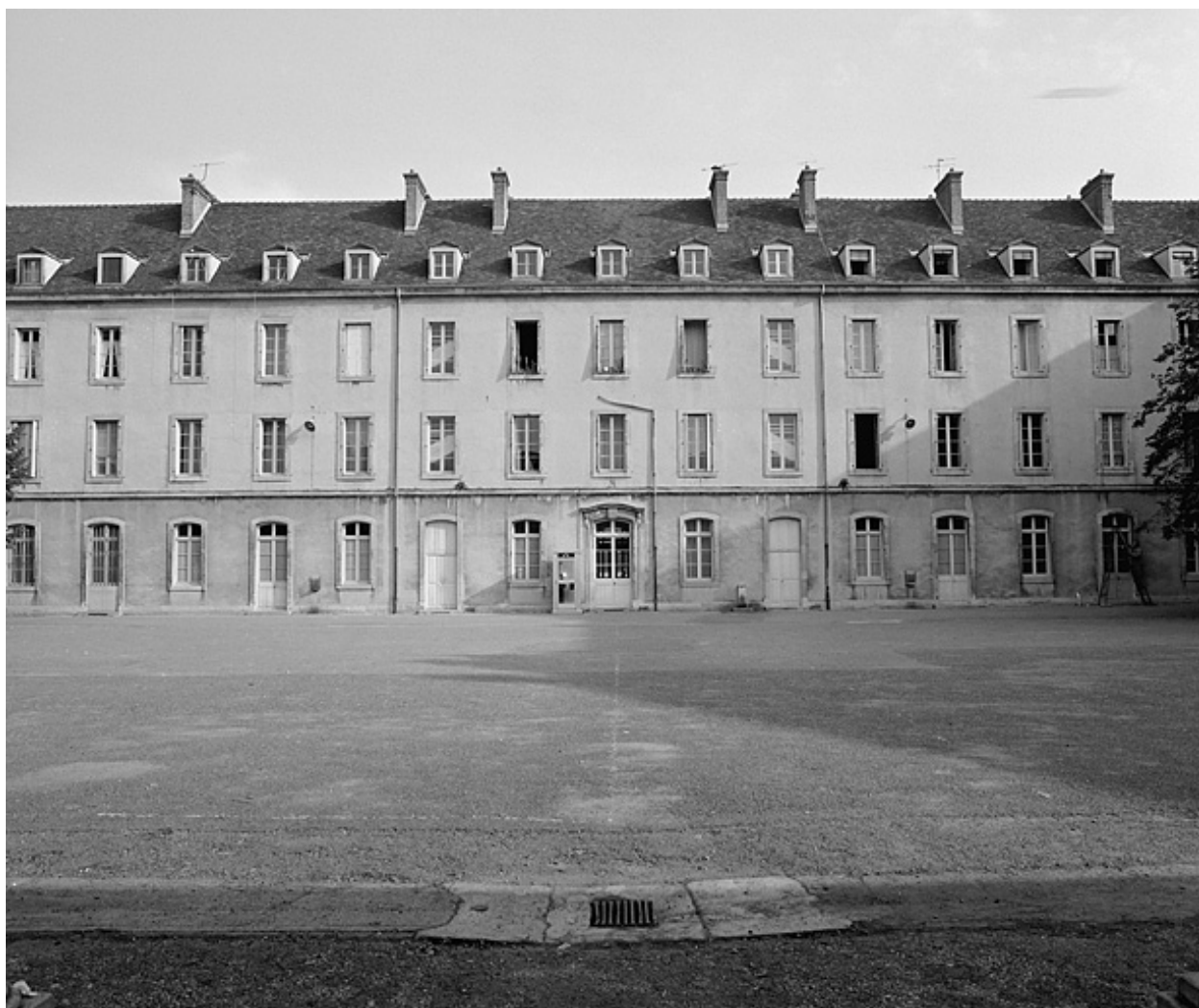
Façade postérieure sur la cour.
