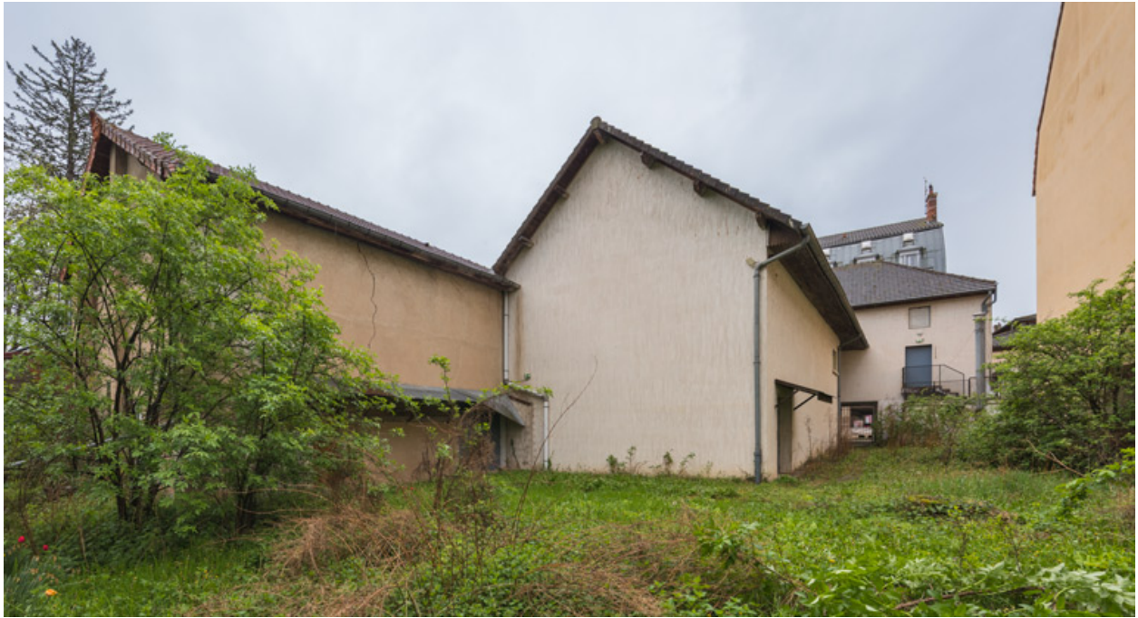
Façades postérieure et latérale gauche.
