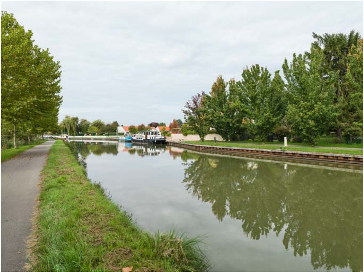
Vue d'ensemble du port.
