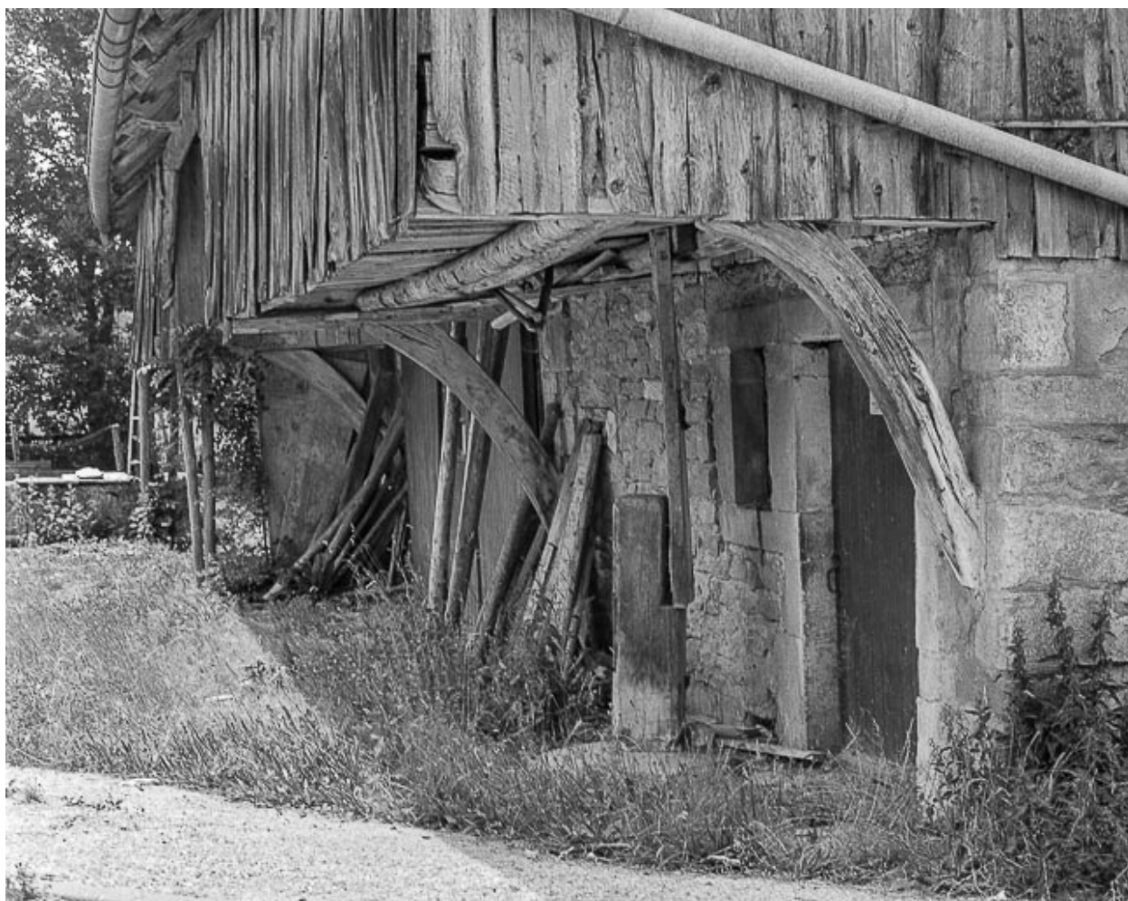
Galerie en bois protégeant un mur goutterot.
