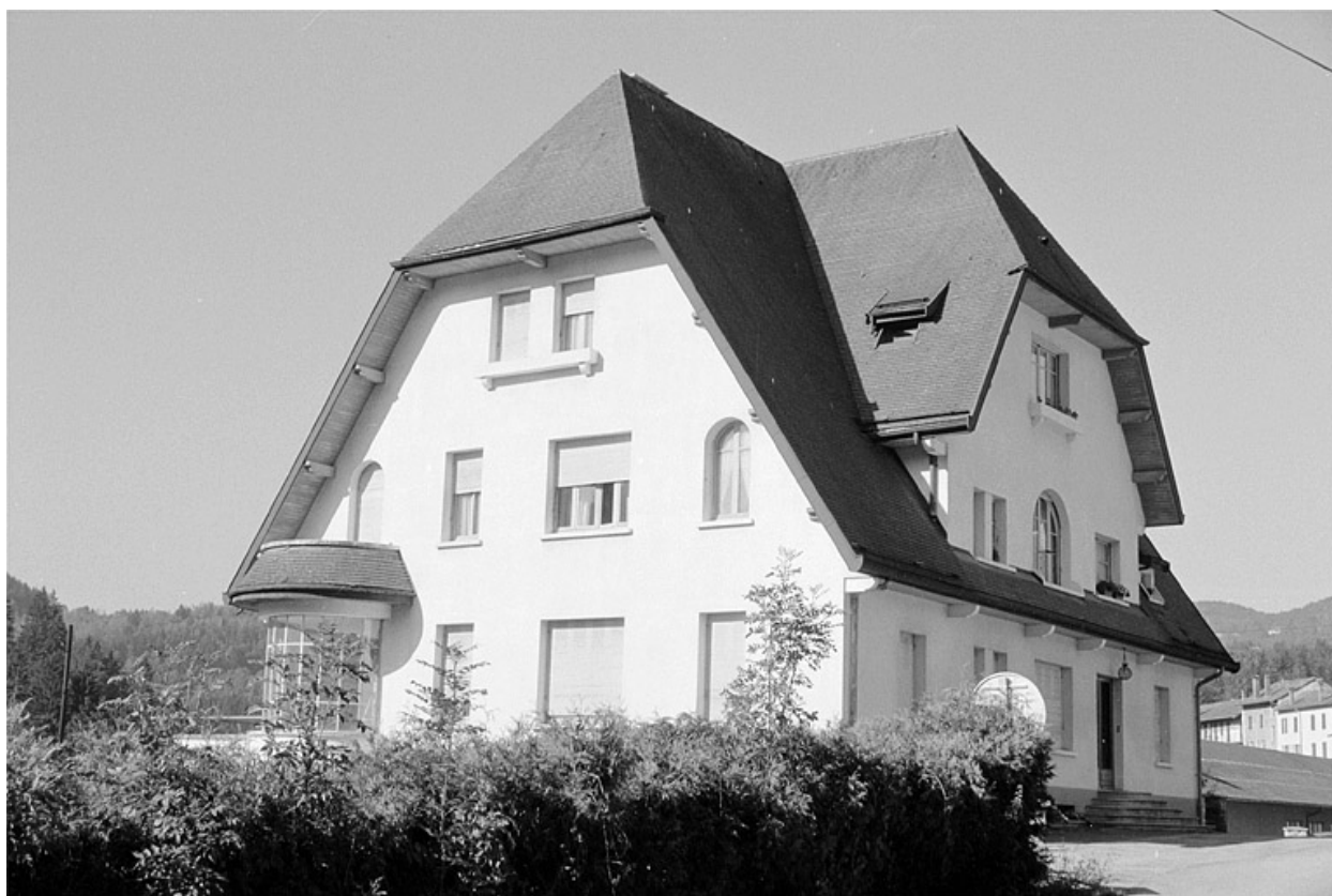
Logement patronal, de trois quarts gauche.
