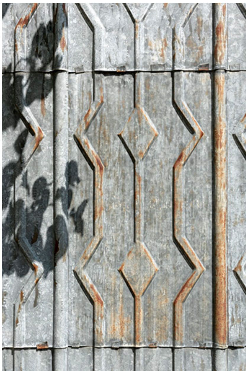
Façade latérale gauche : détail de l'essentage métallique.
