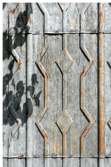
Façade latérale gauche : détail de l'essentage métallique. Phot. Sonia Dourlot IVR43_20192500426NUC4A
