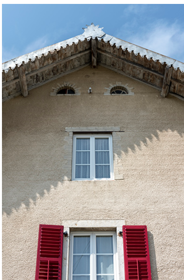
Façade antérieure : pignon. Phot. Sonia Dourlot IVR43_20192500427NUC4A
