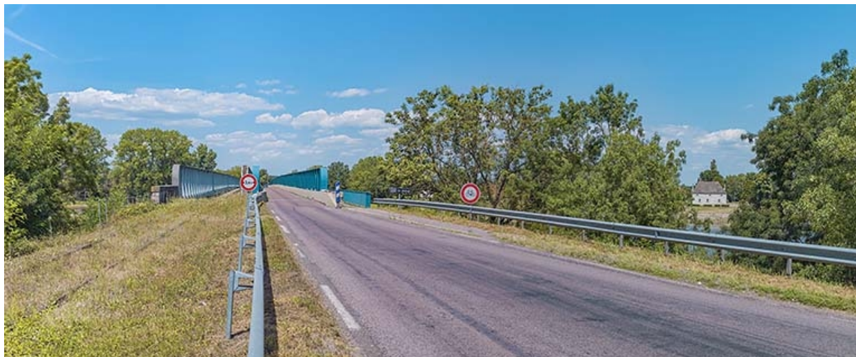
Vue d'ensemble des deux voies du pont.
