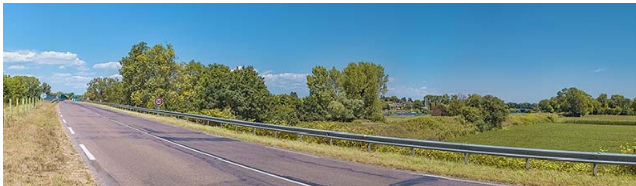
Chauvort et le pont, vue d'ensemble.
