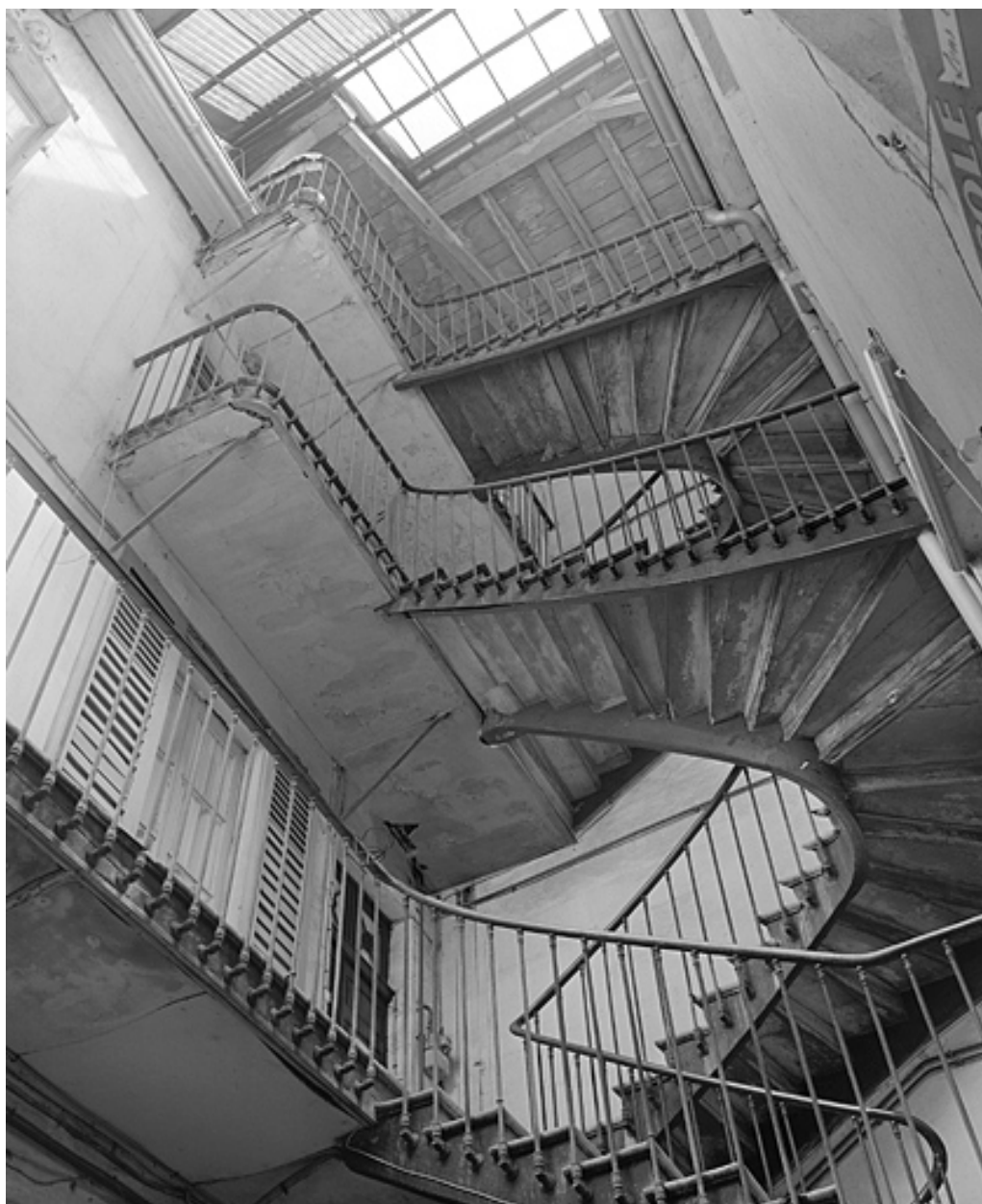
L'escalier, vue générale.
