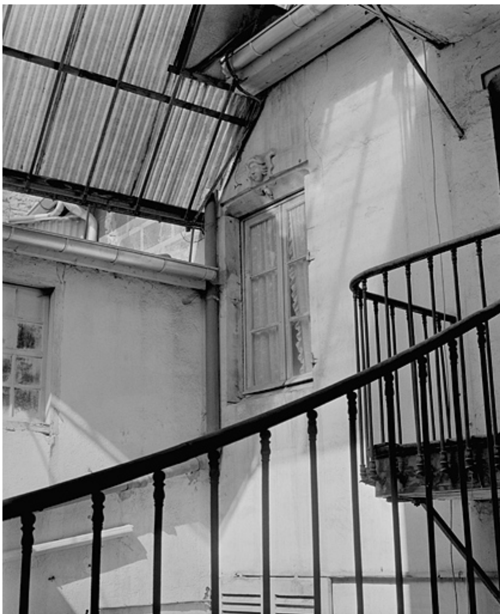
2e étage, fenêtre de gauche.
