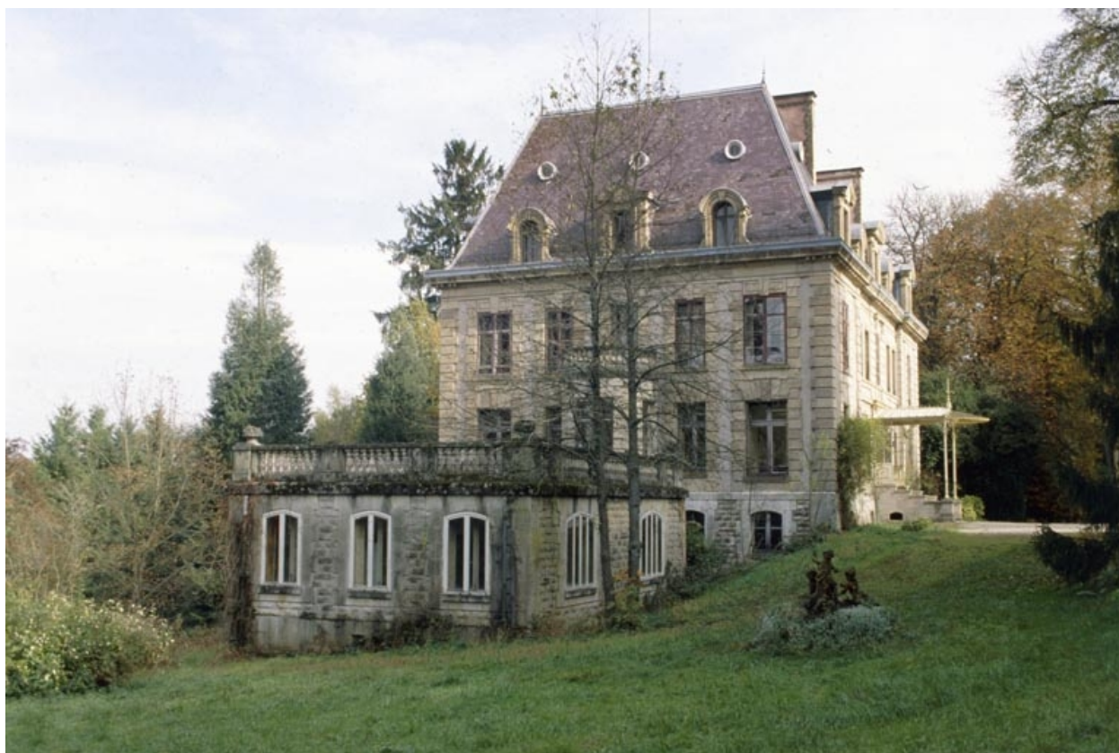
Vue depuis l'ouest.
