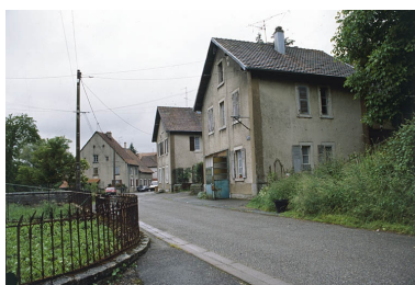
L'écurie depuis l'ouest. Phot. Yves Sancey IVR43_20009000479ZA
