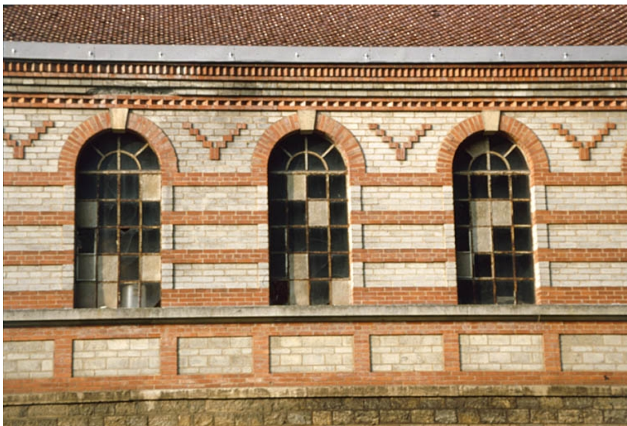
Détail de la façade est de l'orangerie.
