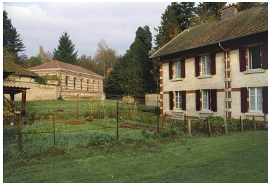
Dépendances au sud. Phot. Yves Sancey IVR43_20009000789ZA
