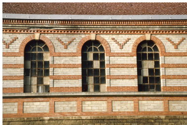
Détail de la façade est de l'orangerie. Phot. Yves Sancey IVR43_20009000794ZA
