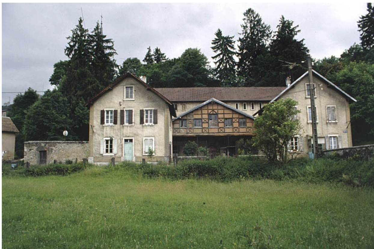
Vue d'ensemble de l'écurie.
