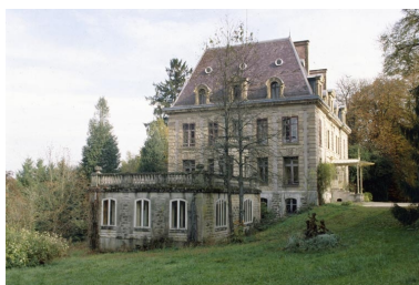
Vue depuis l'ouest.
