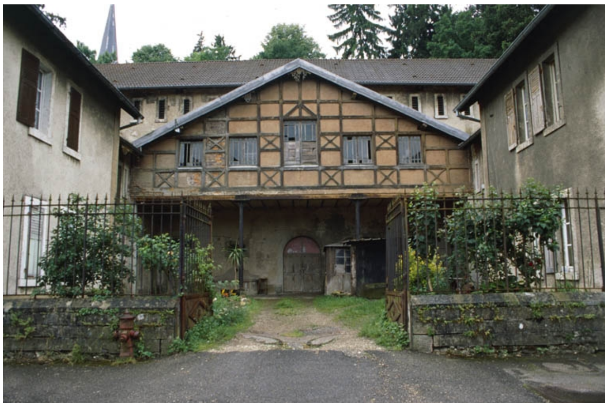
Façade nord de l'écurie.
