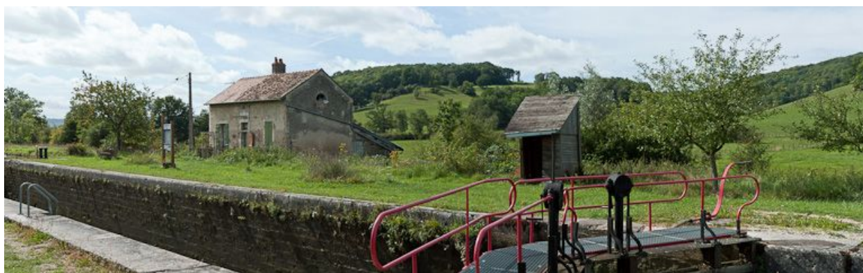
Vue d'ensemble du site d'écluse.
