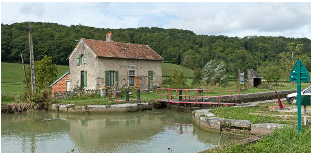
Vue du site d'écluse depuis l'amont.
