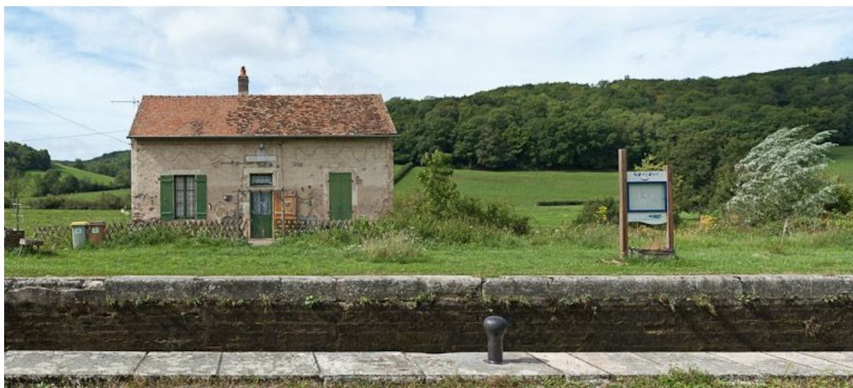
Vue de face de la maison éclusière.
