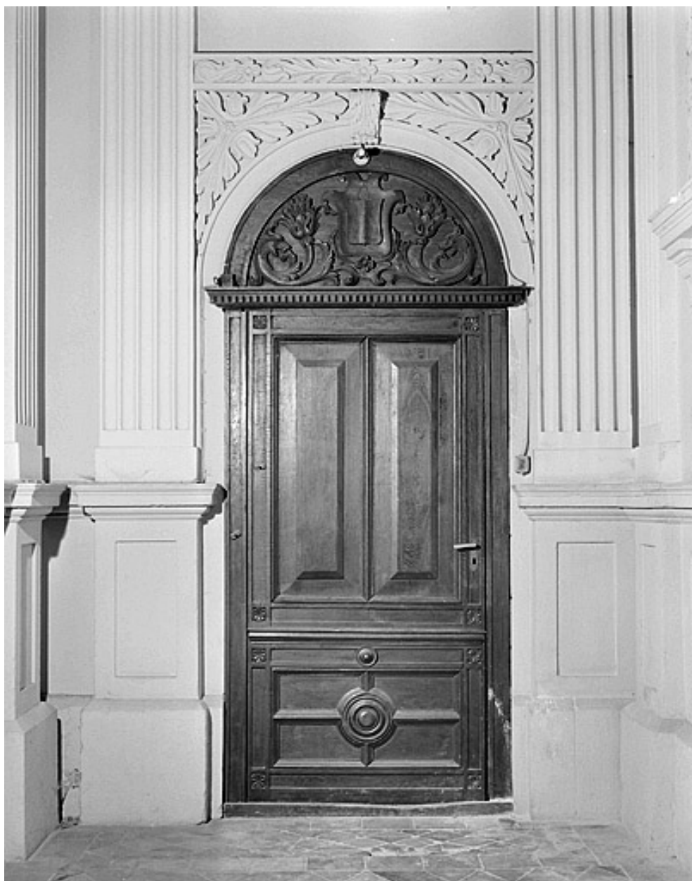
Vestibule, porte d'accès à la tour nord.
