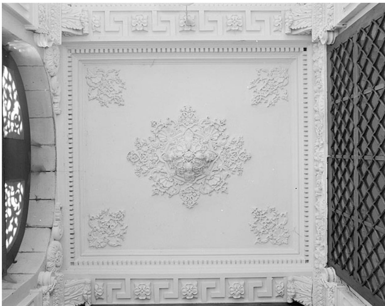
Vestibule, détail du plafond.
