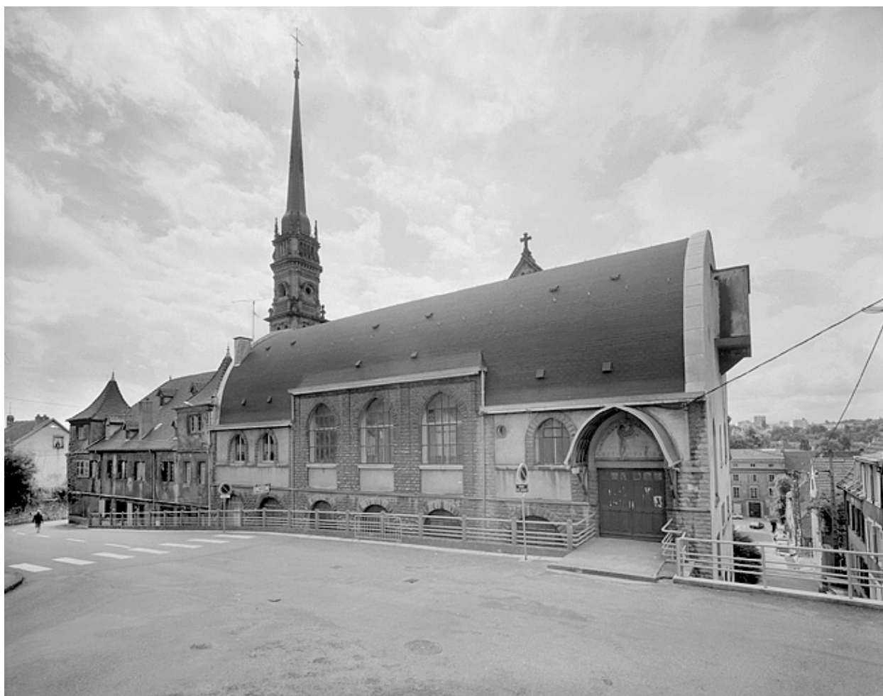
Vue d'ensemble du gymnase.
