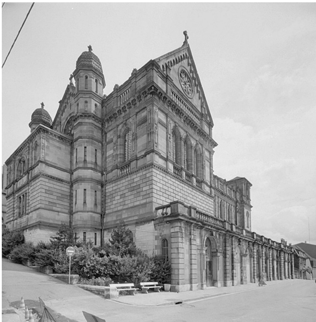
Vue d'ensemble du chevet et du transept.
