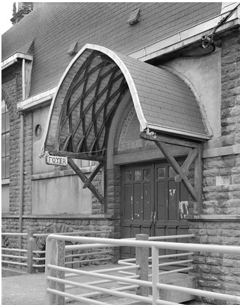
Entrée du gymnase.
