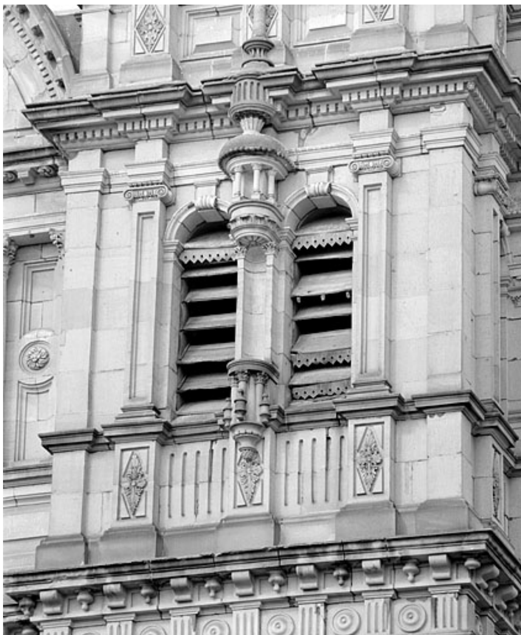
Deuxième niveau de la tour nord.
