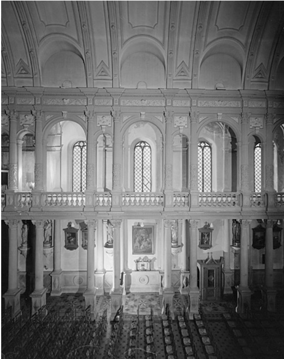
Elévation intérieure droite de la nef.
