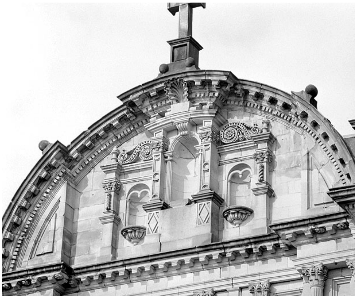
Façade principale, fronton.
