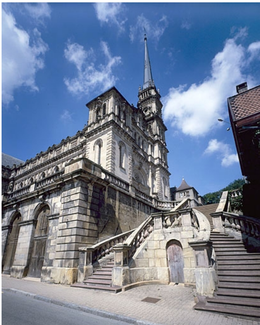
Escalier de la terrasse et façade principale.
