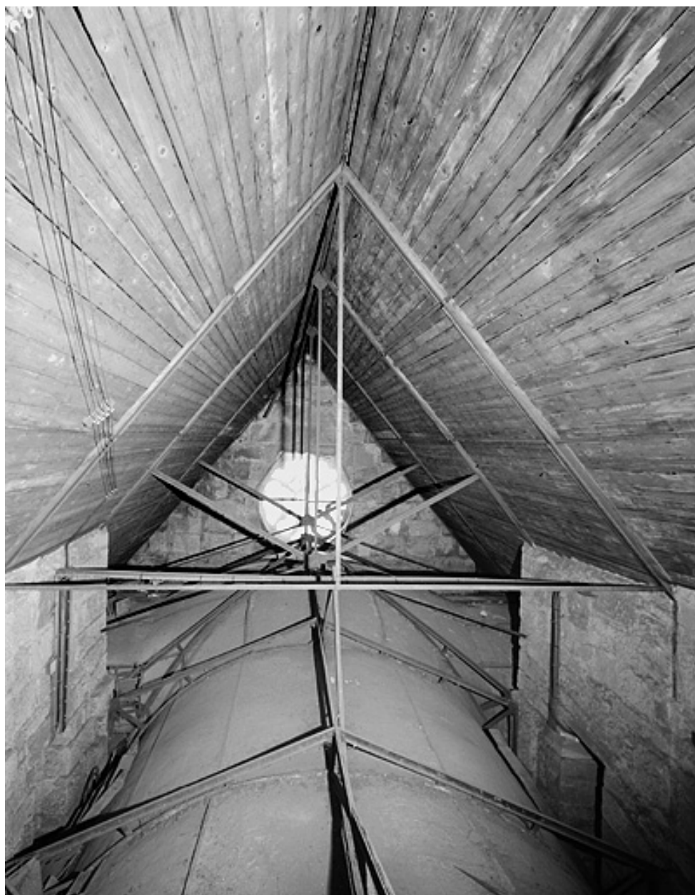
Charpente du transept.
