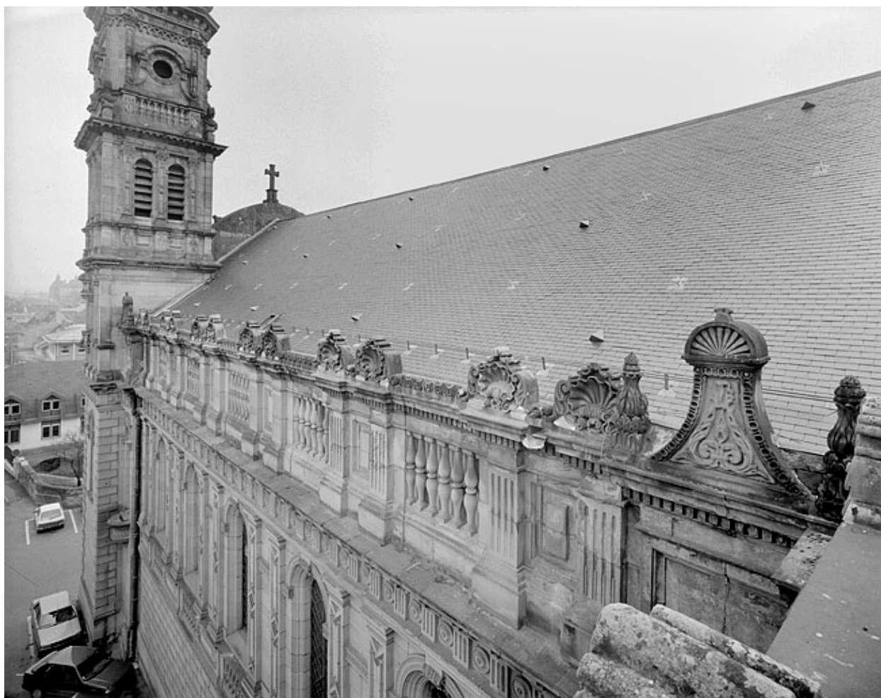
Couronnement de la nef, côté nord.
