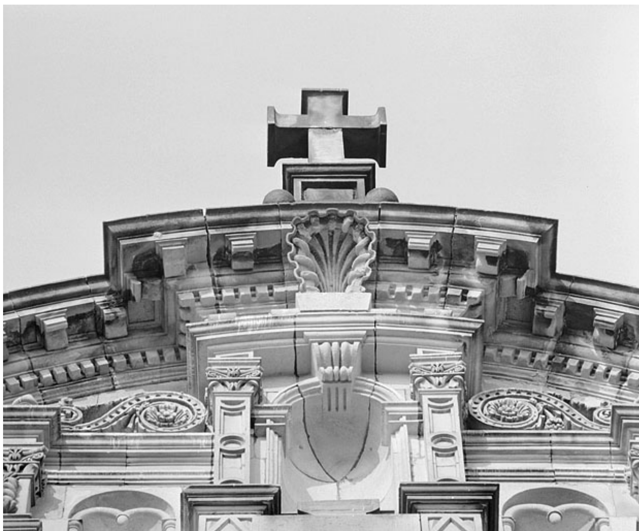
Façade principale, fronton vu d'en dessous.
