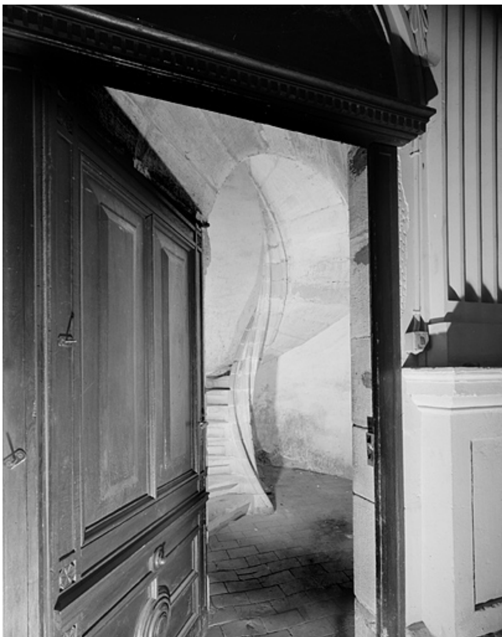
Escalier de la tour nord.
