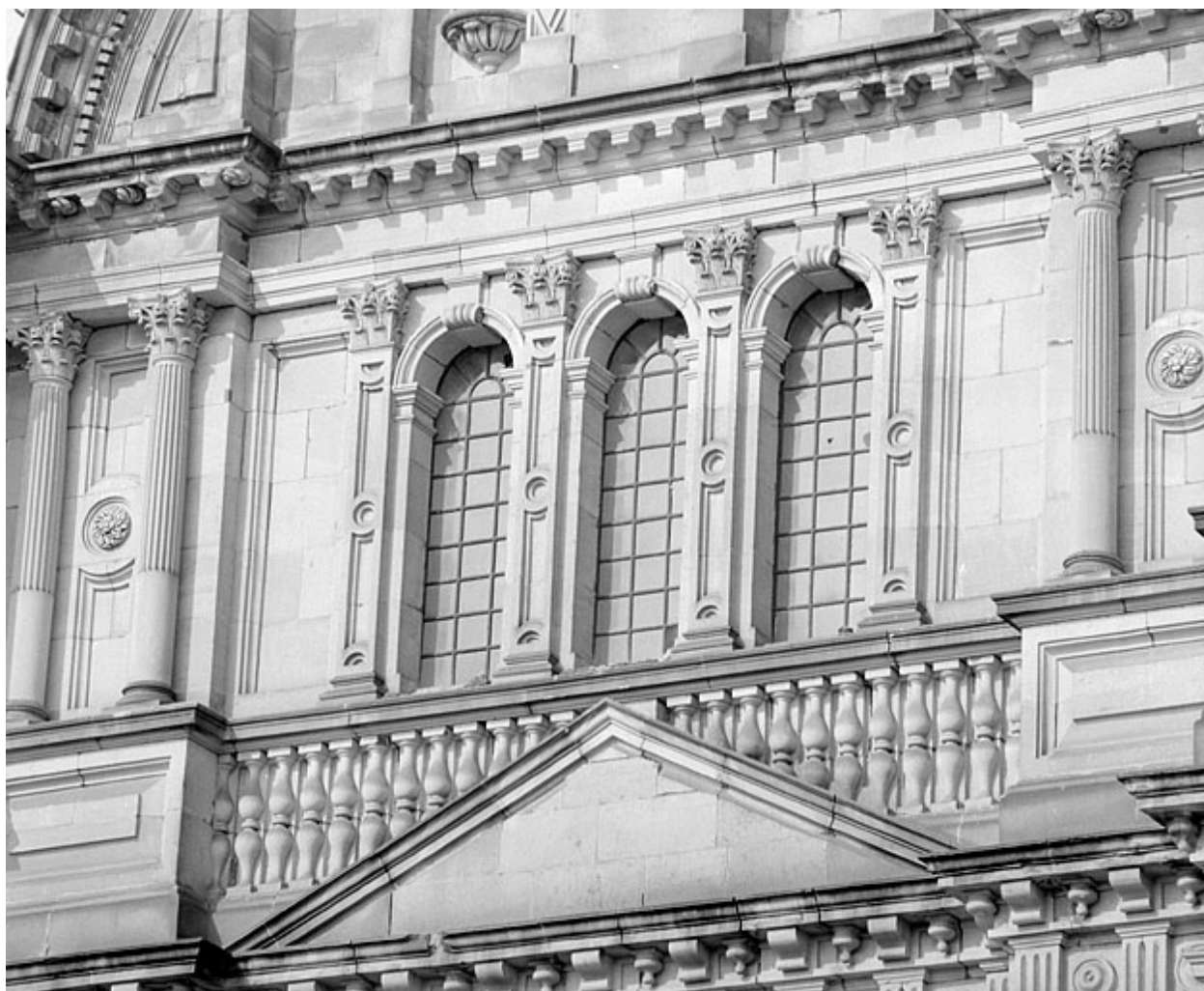
Façade principale, deuxième niveau.
