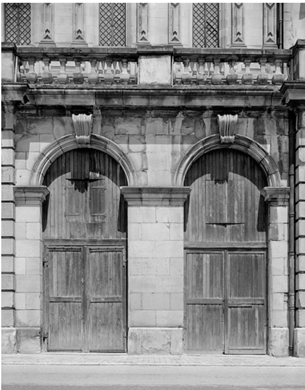
Baies des boutiques.
