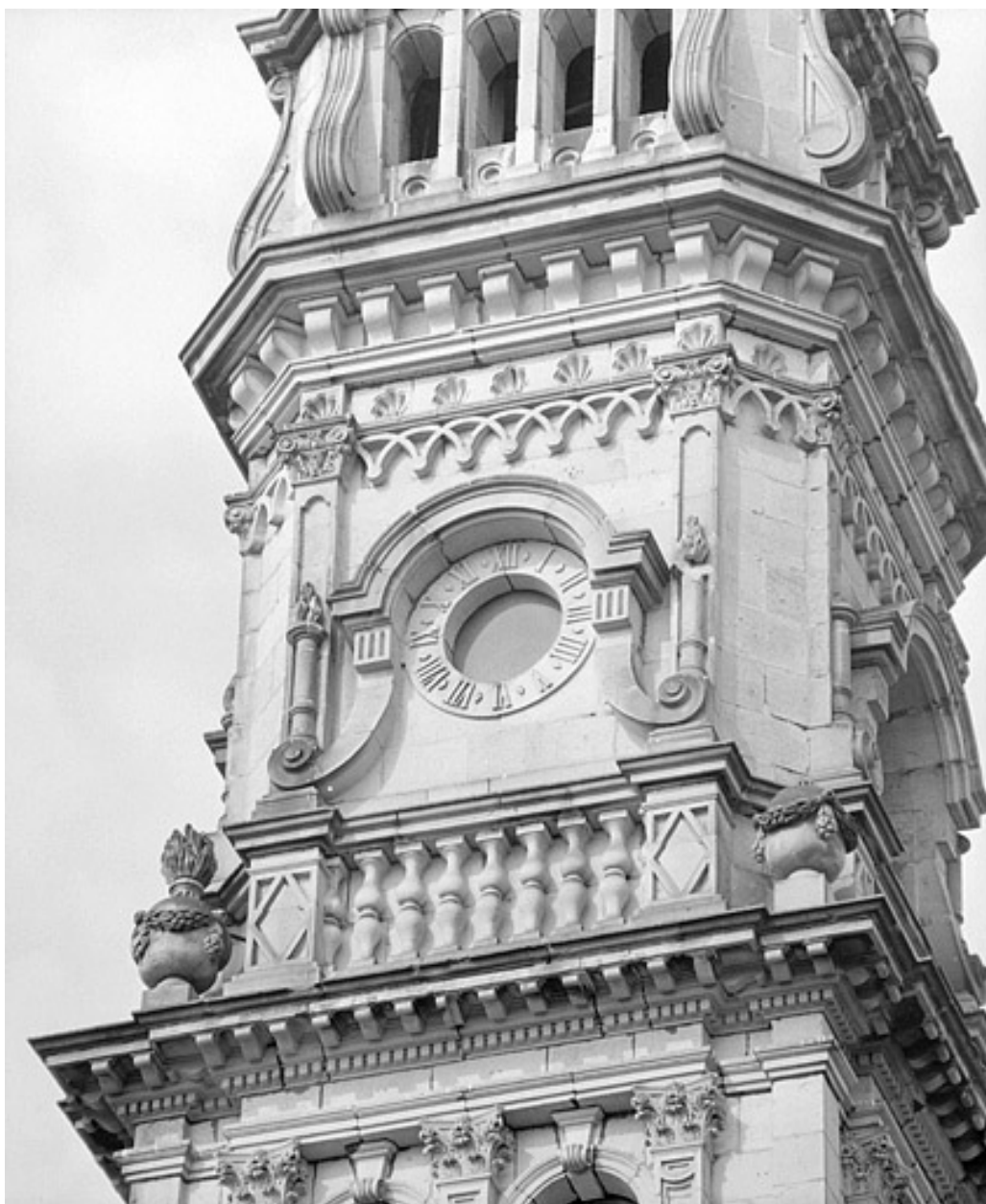
Quatrième niveau de la tour nord.
