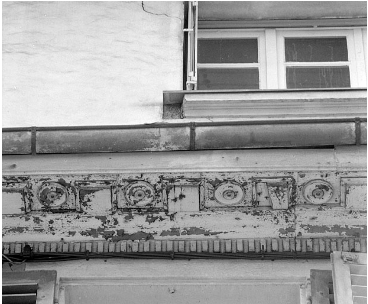
Façade sur rue. Détail de la corniche.
