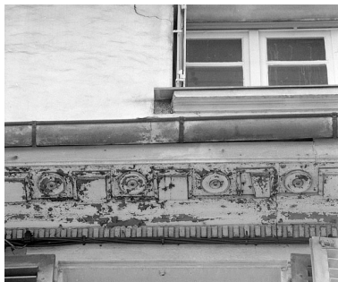
Façade sur rue. Détail de la corniche. Phot. Jérôme Mongreville IVR43_19882500105X
