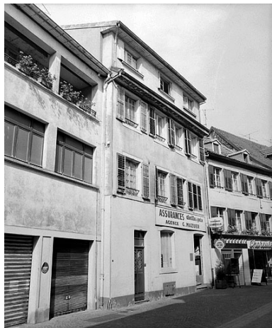
Façade sur rue. Phot. Jérôme Mongreville IVR43_19892500007X
