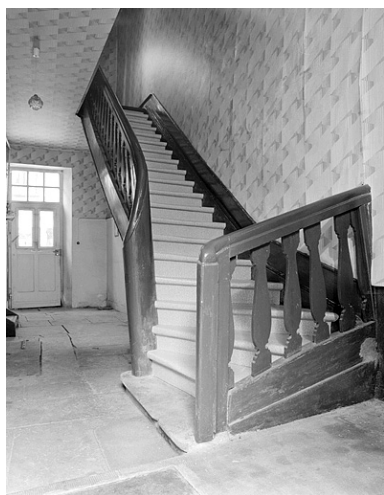
Escalier. Phot. Jérôme Mongreville IVR43_19872500760X
