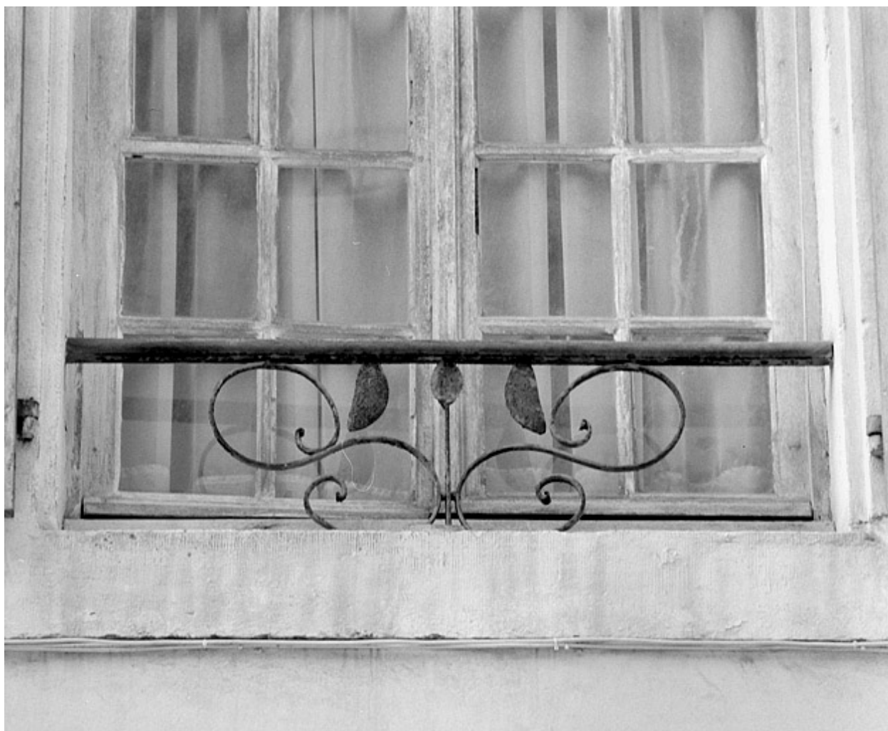
Façade sur rue. Détail d'un balconnet.
