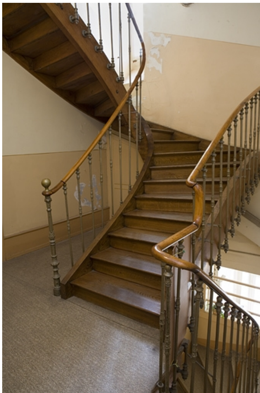
Bâtiment A. Vue de l'escalier.
