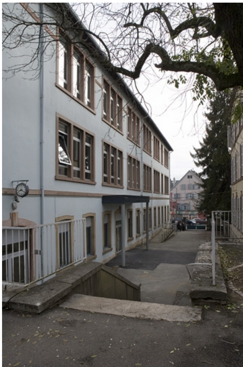
Bâtiment B. Vue face latérale droite.
