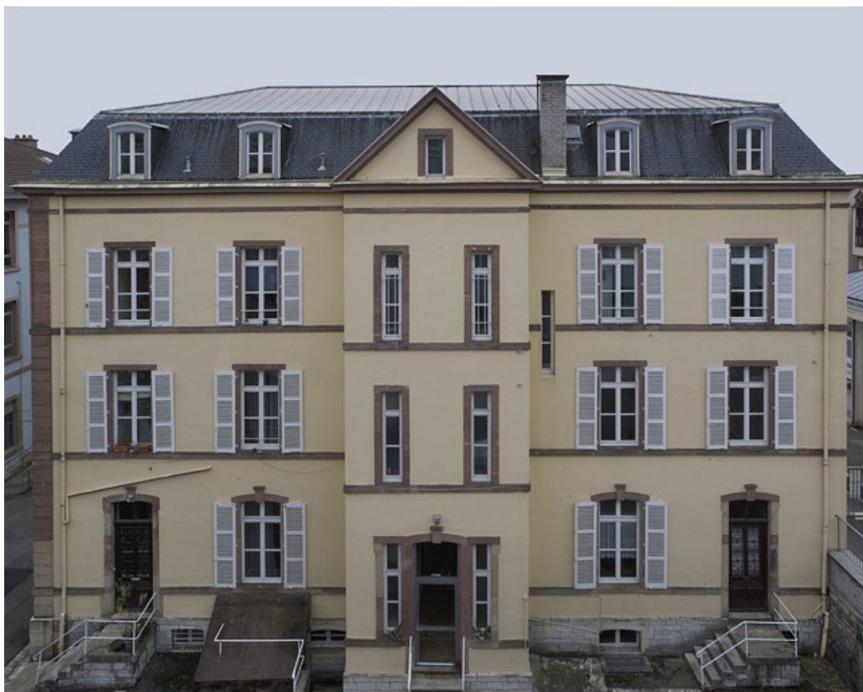
Vue façade postérieure bâtiment A.
