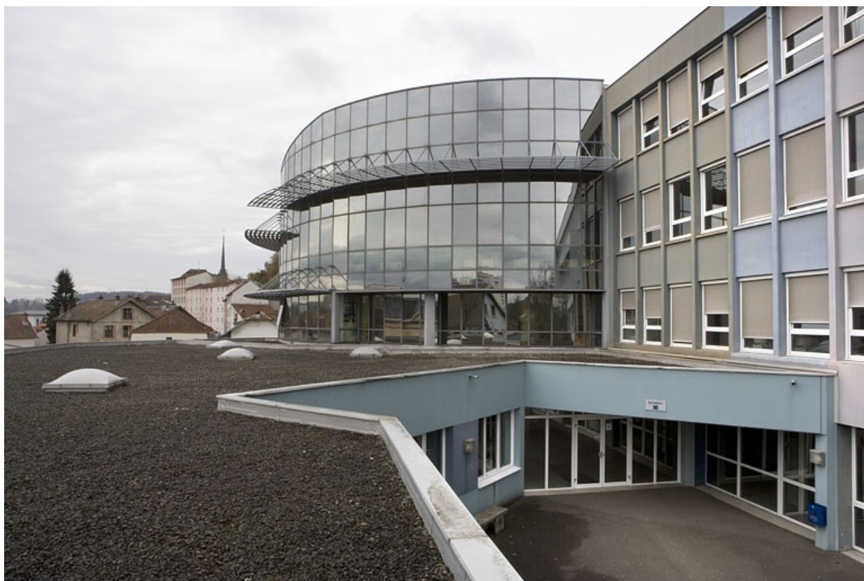
Vue tour bâtiment D depuis le toit.
