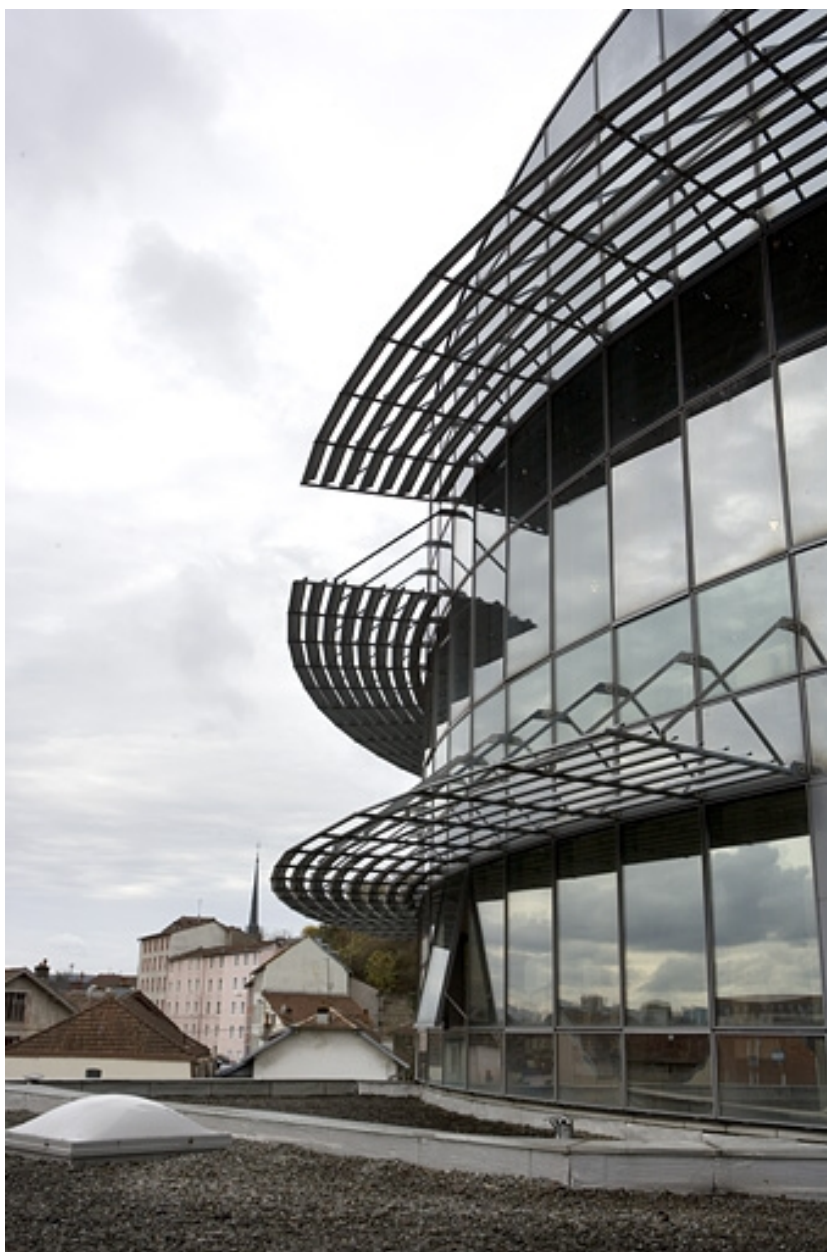
Tour bâtiment D. Détail brise-soleil métalliques.
