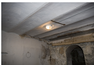
Bâtiment A : sous-sol. Détail voûtains. Phot. Yves Sancey IVR43_20072500945NUCA
