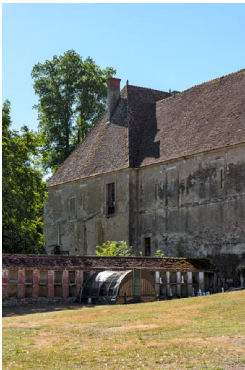
Façade postérieure : pavillon oriental.
