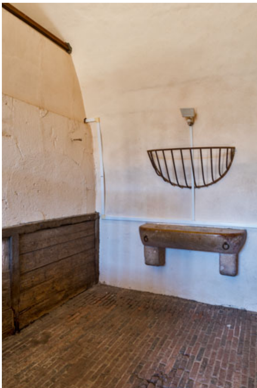
Ecurie, partie occidentale : intérieur d'une stalle.
