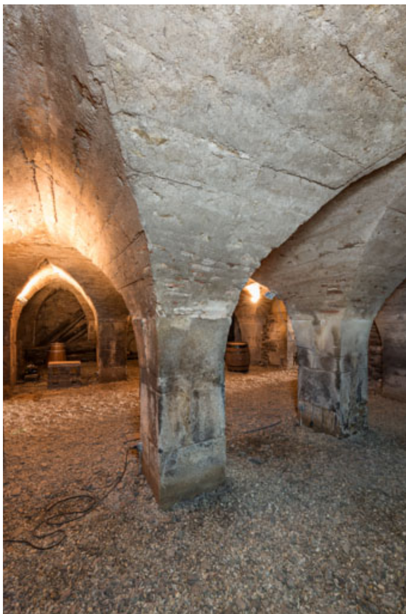
Pavillon occidental : cave à l'étage de soubassement.
