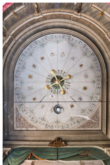
Théâtre : le plafond. Phot. Pierre-Marie Barbe-Richaud IVR26_20227100139NUC4A
