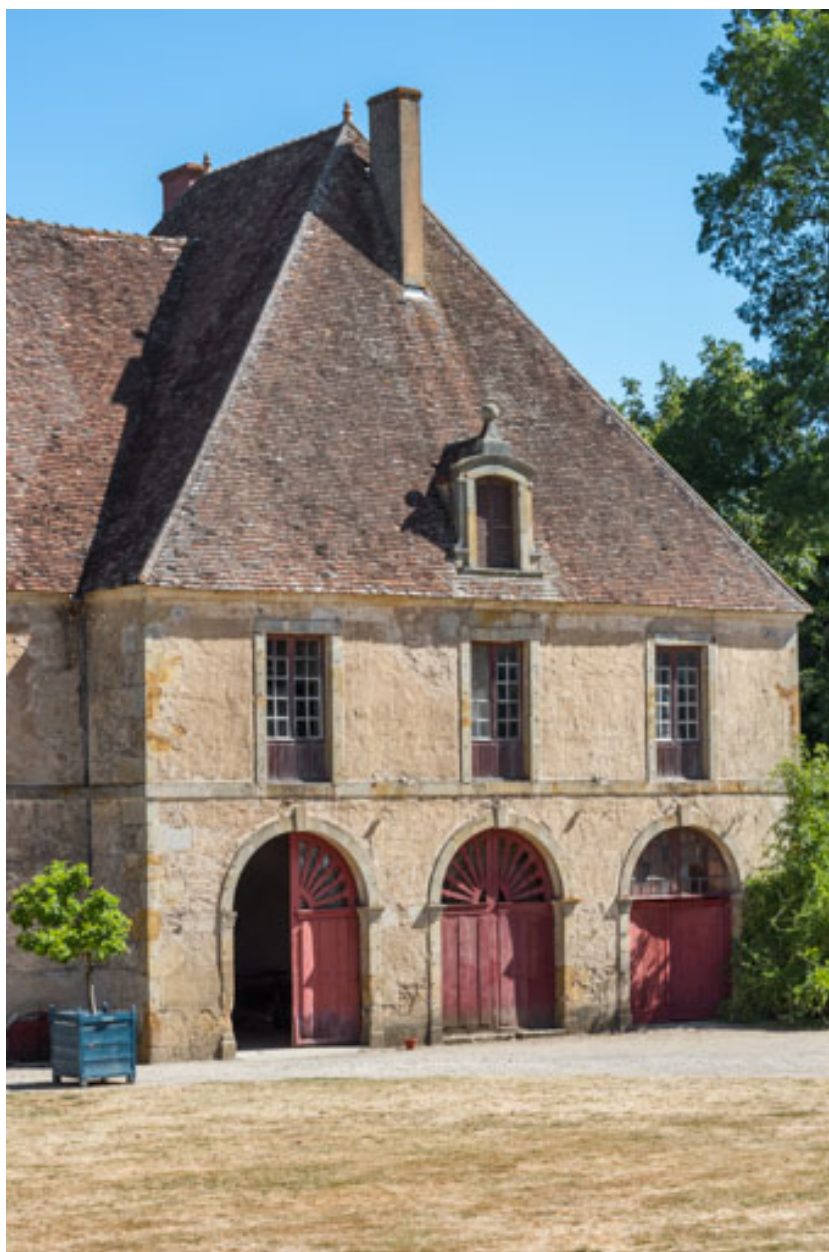
Façade antérieure : pavillon oriental (remises).
