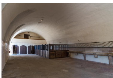
Ecurie : partie occidentale. Phot. Pierre-Marie Barbe-Richaud IVR26_20227100092NUC4A
