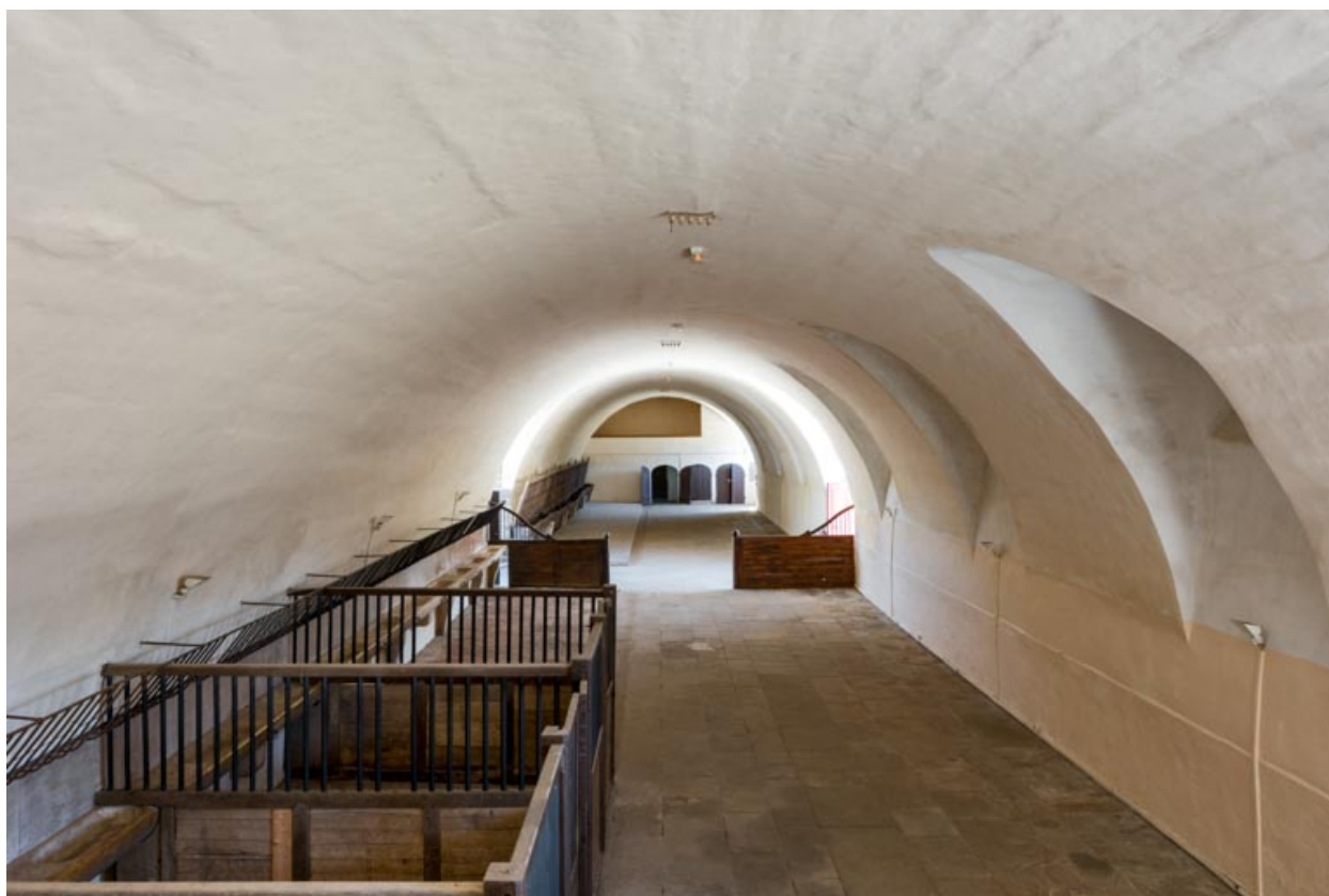
Ecurie : la voûte depuis la tribune occidentale.
