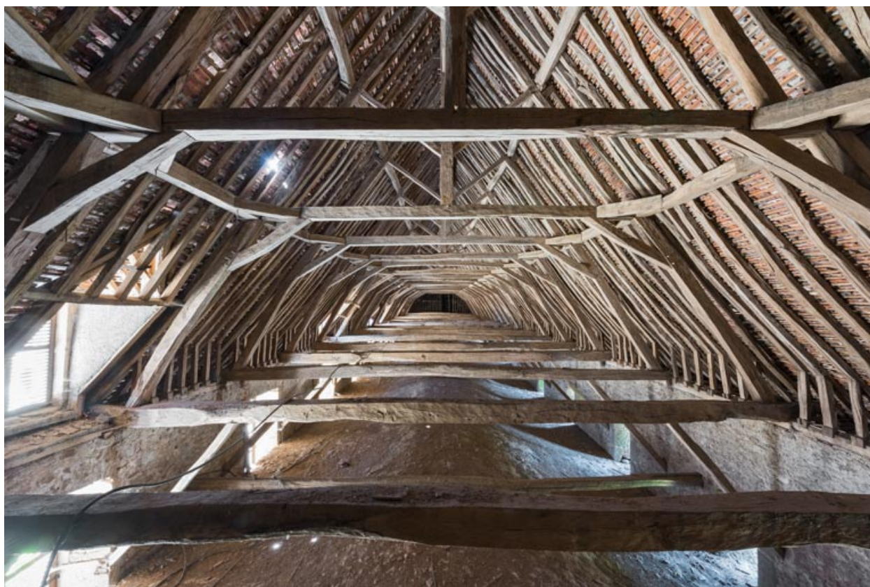
Ecurie, étage de comble : charpente.
