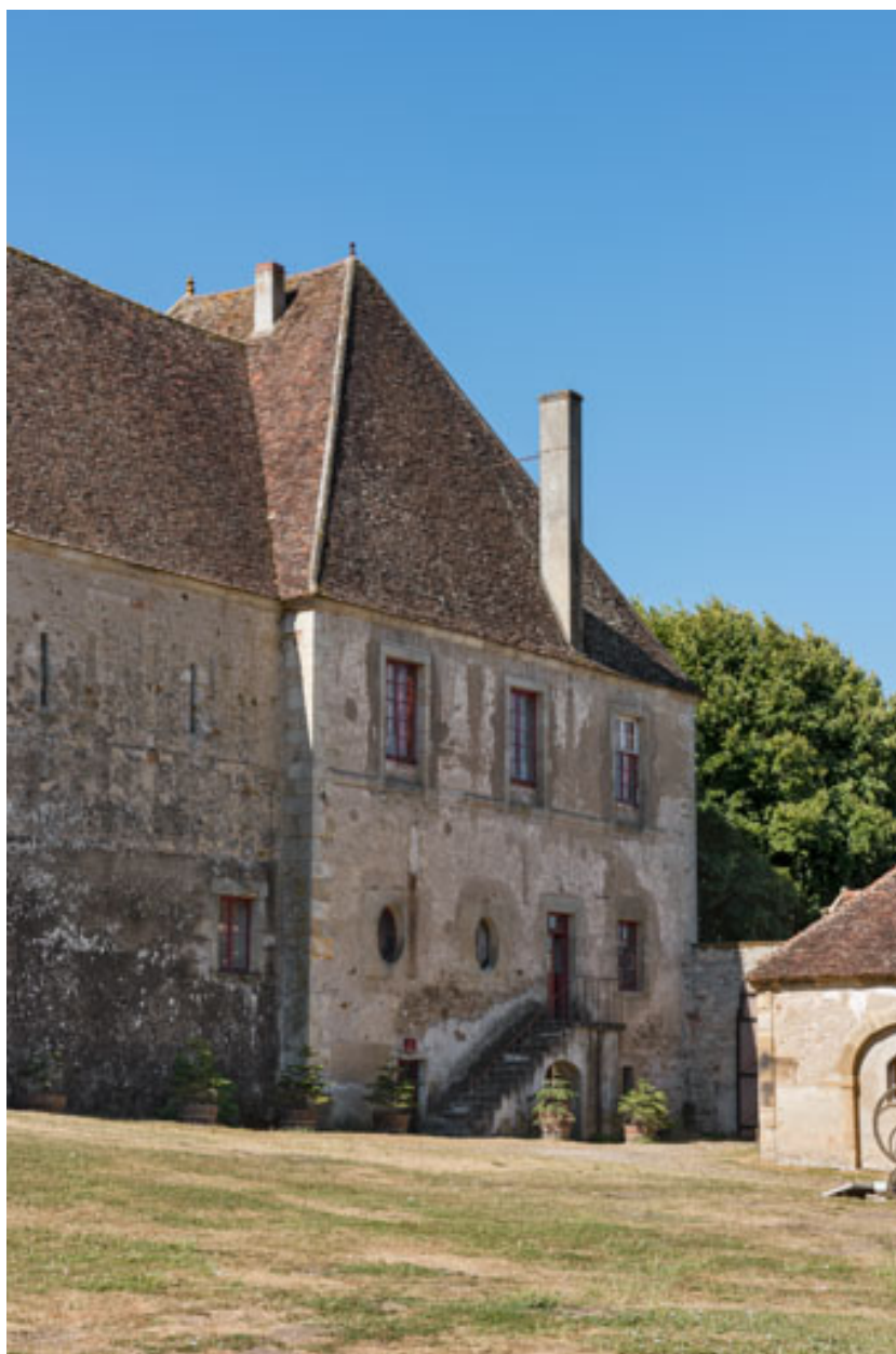
Façade postérieure : pavillon occidental.
