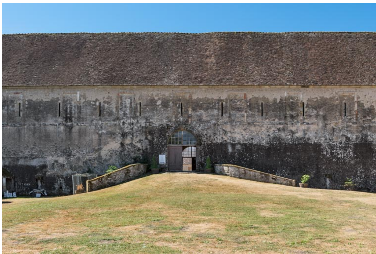
Façade postérieure : corps central.
