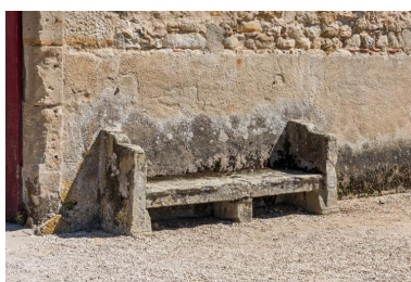
Façade antérieure : banc. Phot. Pierre-Marie Barbe-Richaud IVR26_20227100089NUC4A
