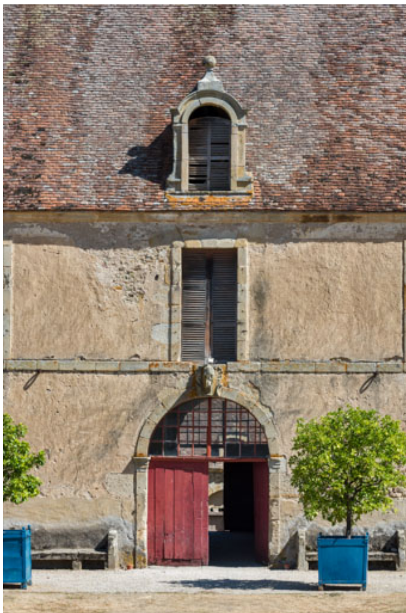
Façade antérieure : travée centrale.
