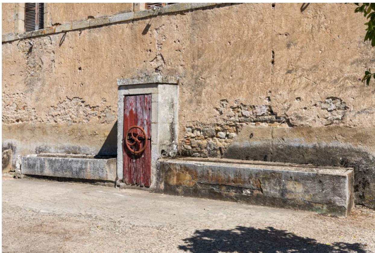
Façade antérieure : abreuvoir.
