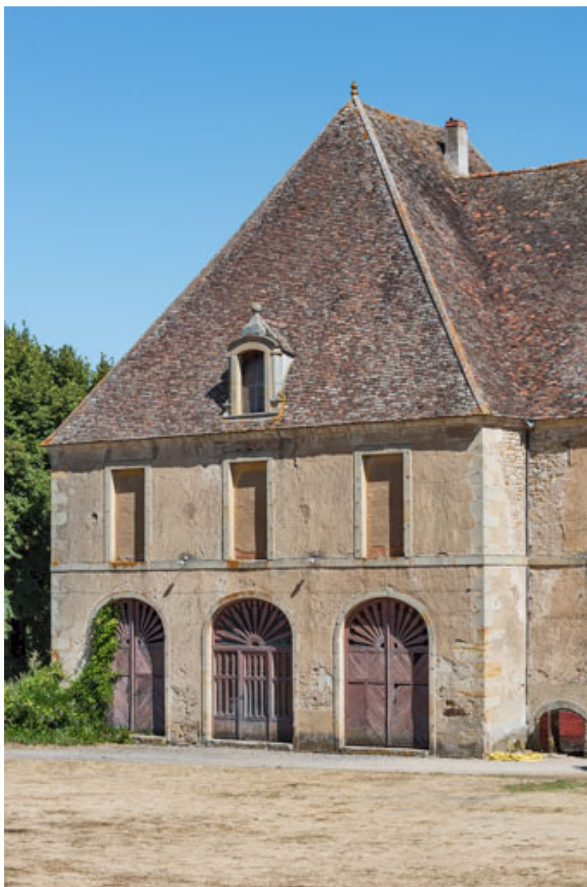
Façade antérieure : pavillon occidental (théâtre).
