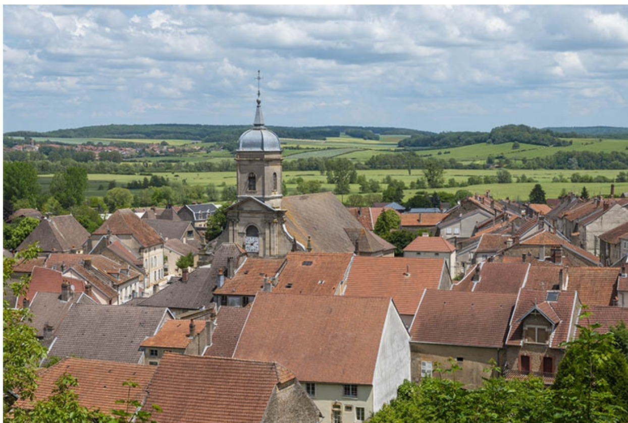
Vue générale depuis le sud-ouest.
