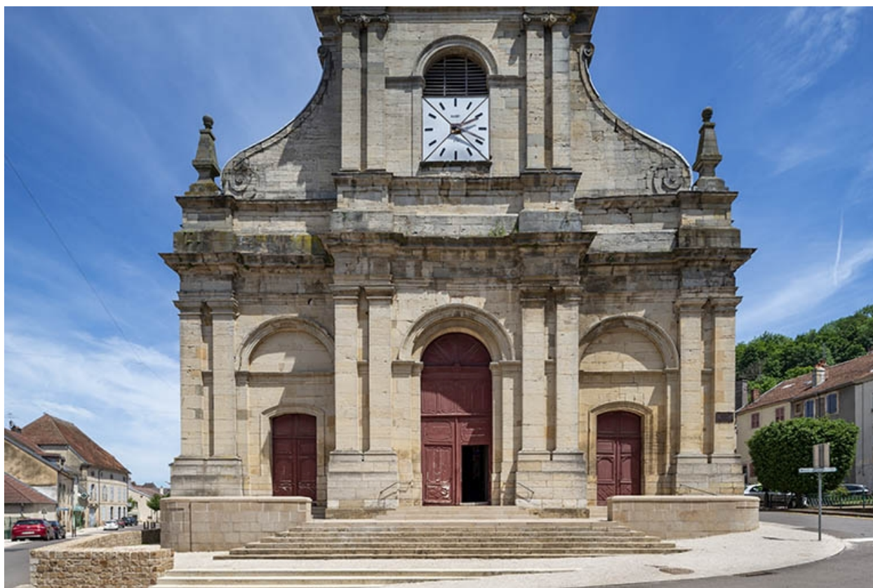
Premier niveau de la façade antérieure.
