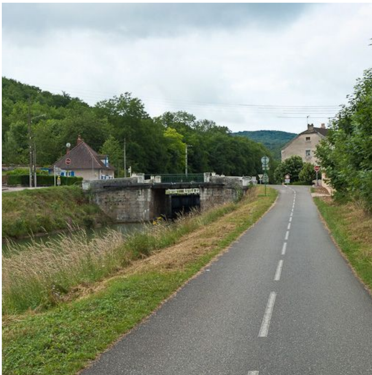
Vue du pont sur écluse depuis l'aval.
