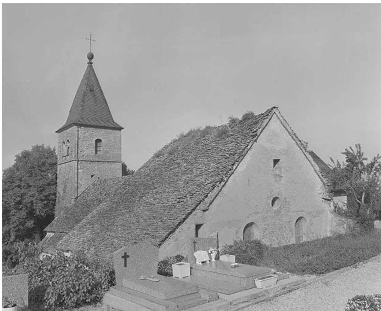
Façade latérale droite et chevet.
