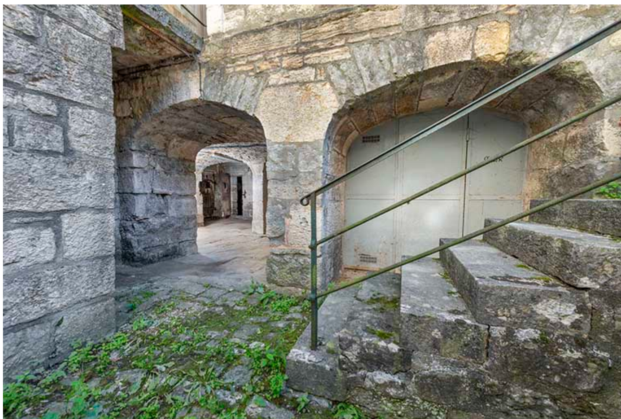
Cour ouest. Accès aux cellules de prison.
