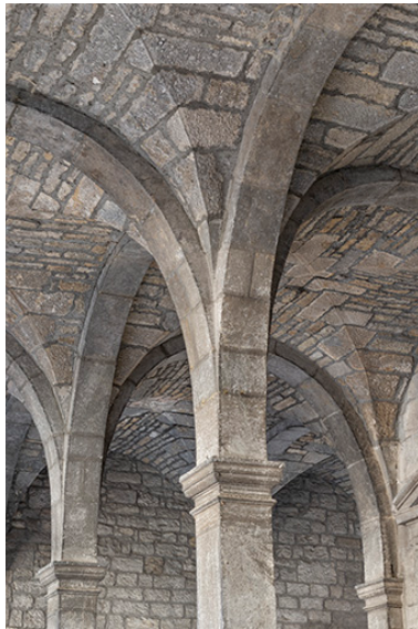
Détail des voûtes d'arêtes. Phot. Jérôme Mongreville IVR43_20223901276NUC4A
