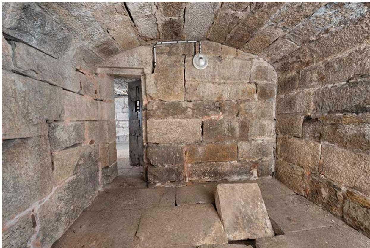
Intérieur d'une cellule.
