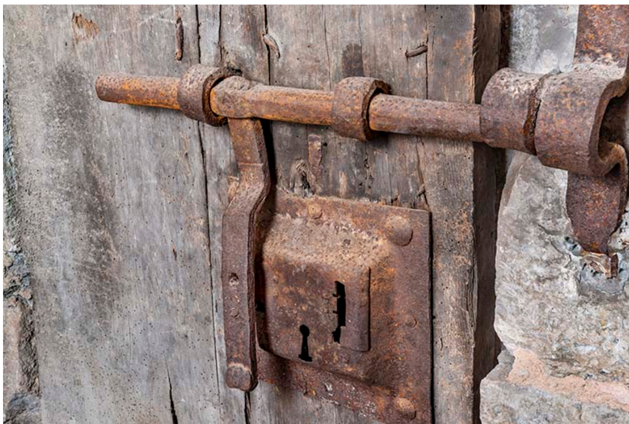
Porte de cellule. Détail d'un verrou.
