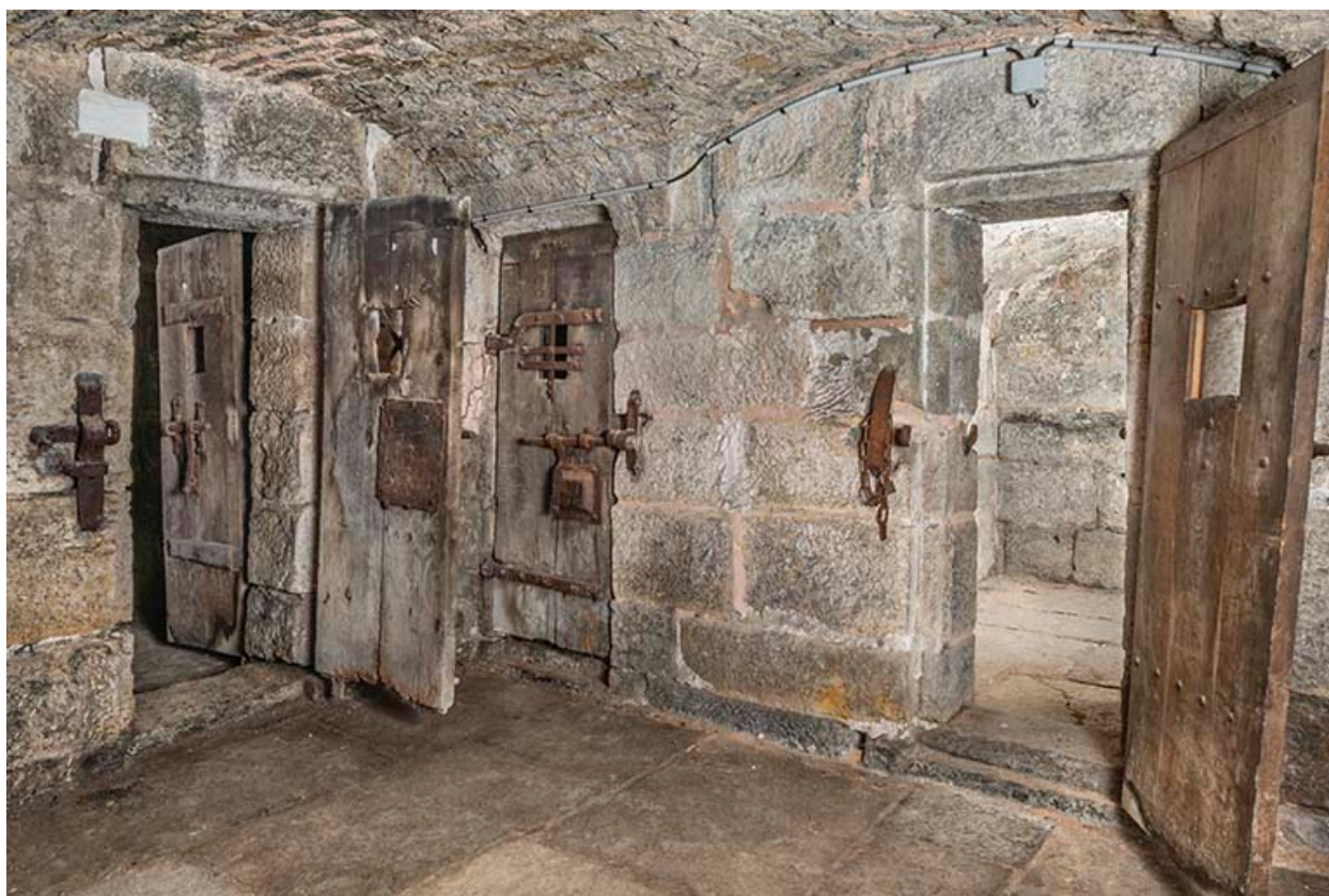
Portes de cellule.
