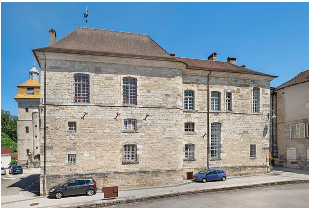
Elévation sud, depuis le sud-ouest.
