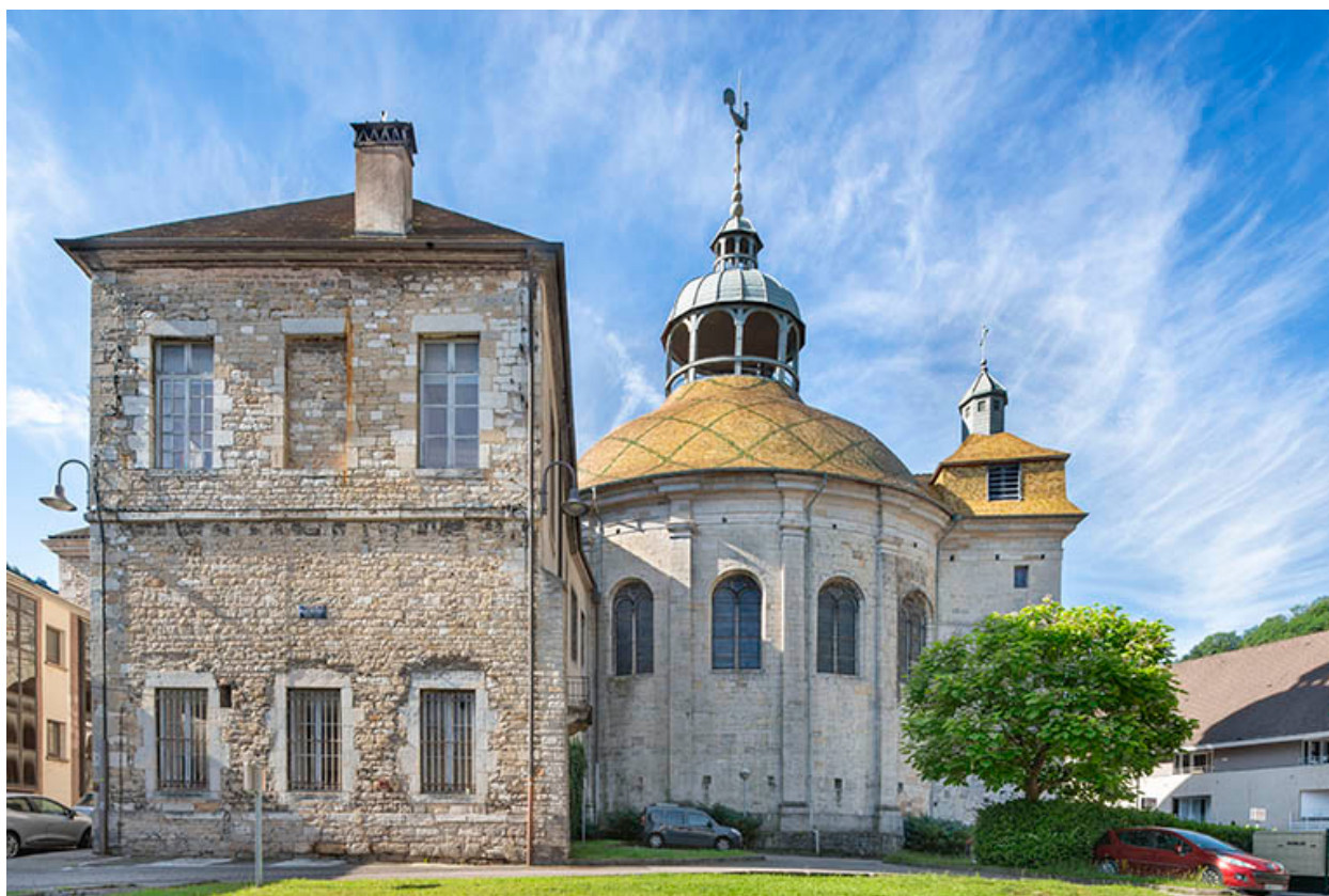
Vue rapprochée, depuis le nord.
