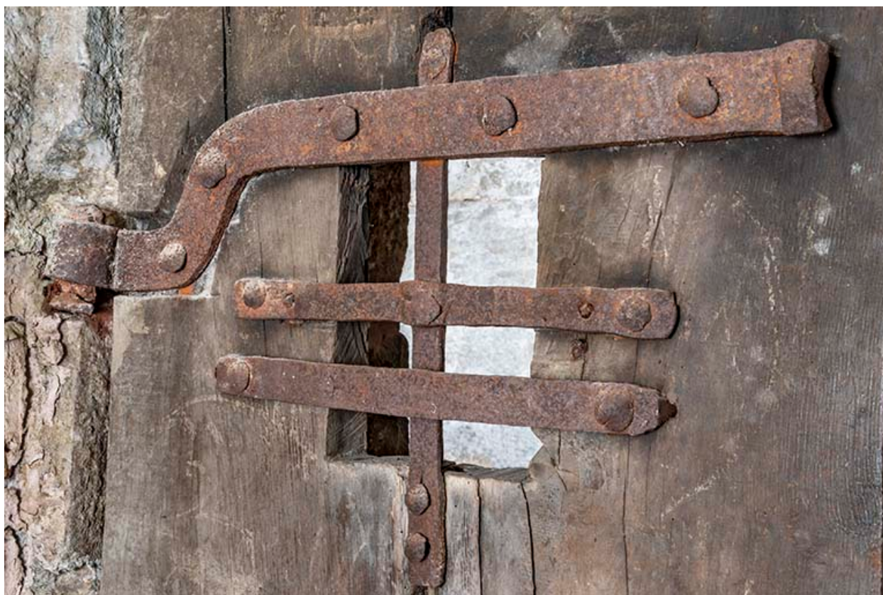
Porte de cellule. Détail d'une fenêtre ferrée.
