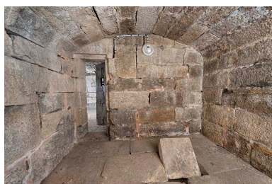
Intérieur d'une cellule. Phot. Jérôme Mongreville IVR43_20233900780NUC4A
