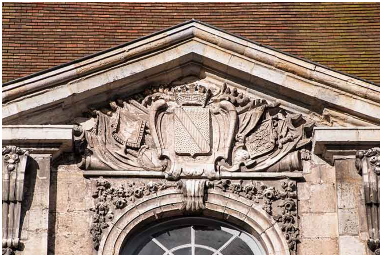
Détail du fronton de la façade est.
