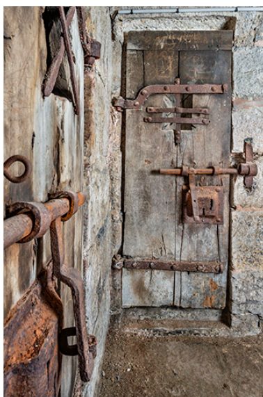
Portes et ferrures. Phot. Jérôme Mongreville IVR43_20233900774NUC4A
