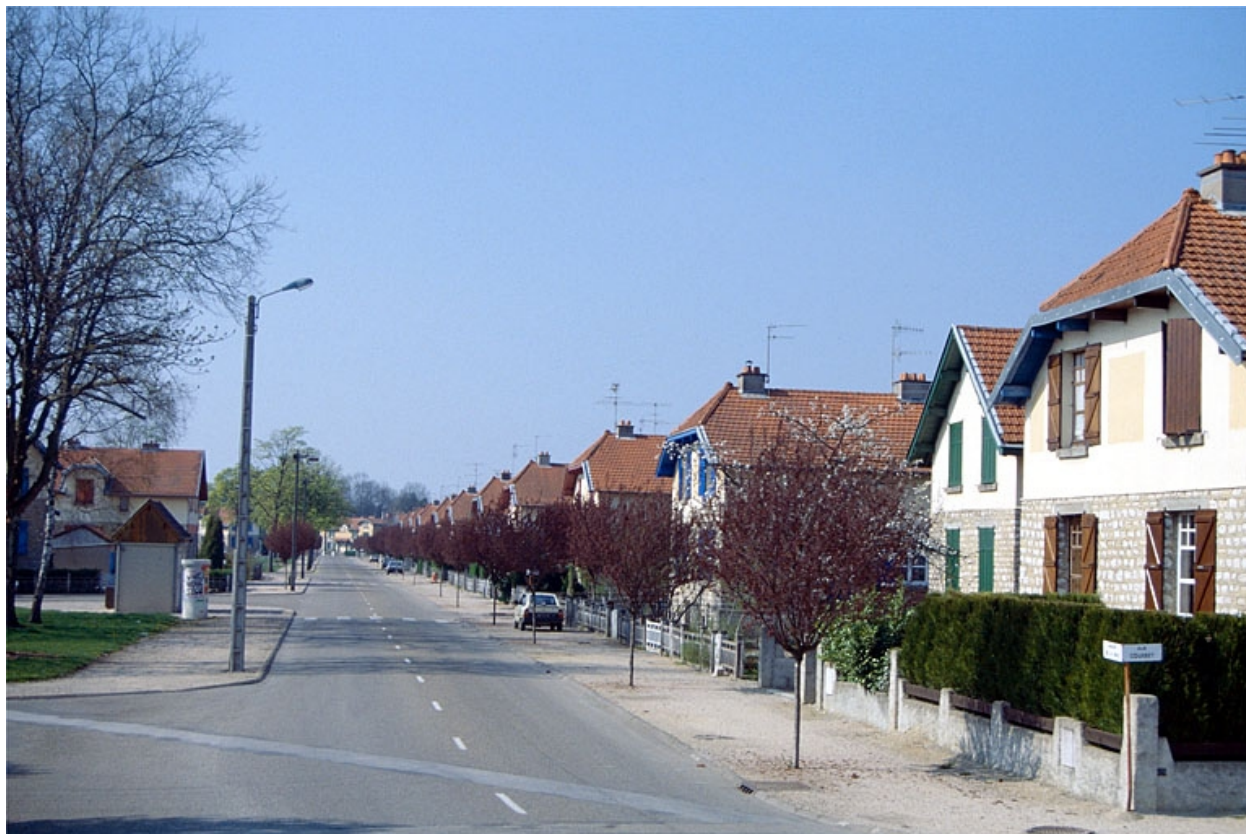
Vue générale de l'avenue de la Paix.
