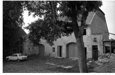
Vue d'ensemble de la ferme. Phot. Bernard Lardière IVR43_19797000015Z
