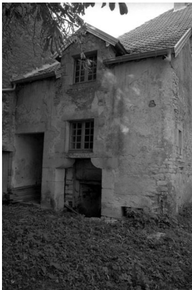
Partie gauche de la ferme. Phot. Bernard Lardière IVR43_19797000016Z
