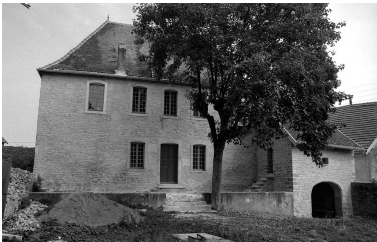
Vue d'ensemble de la maison d'habitation.
