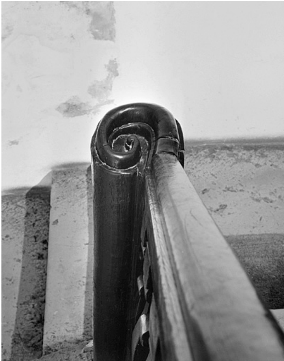
Détail du départ de la rampe d'appui.
