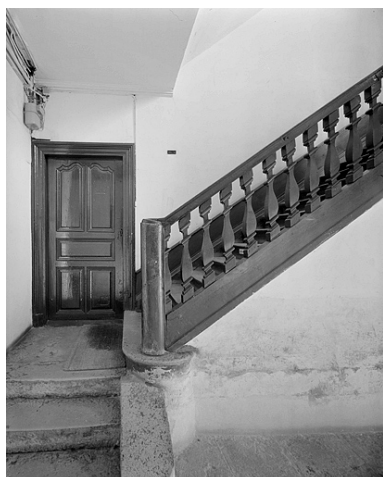
Escalier au niveau du rez-de-chaussée. Phot. Jérôme Mongreville IVR43_19872501267V
