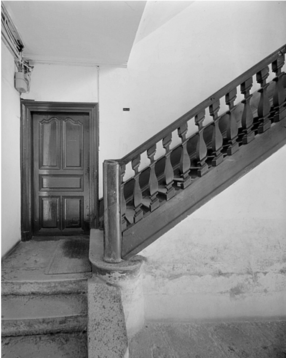
Escalier au niveau du rez-de-chaussée.
