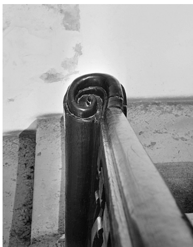
Détail du départ de la rampe d'appui. Phot. Jérôme Mongreville IVR43_19872500485X
