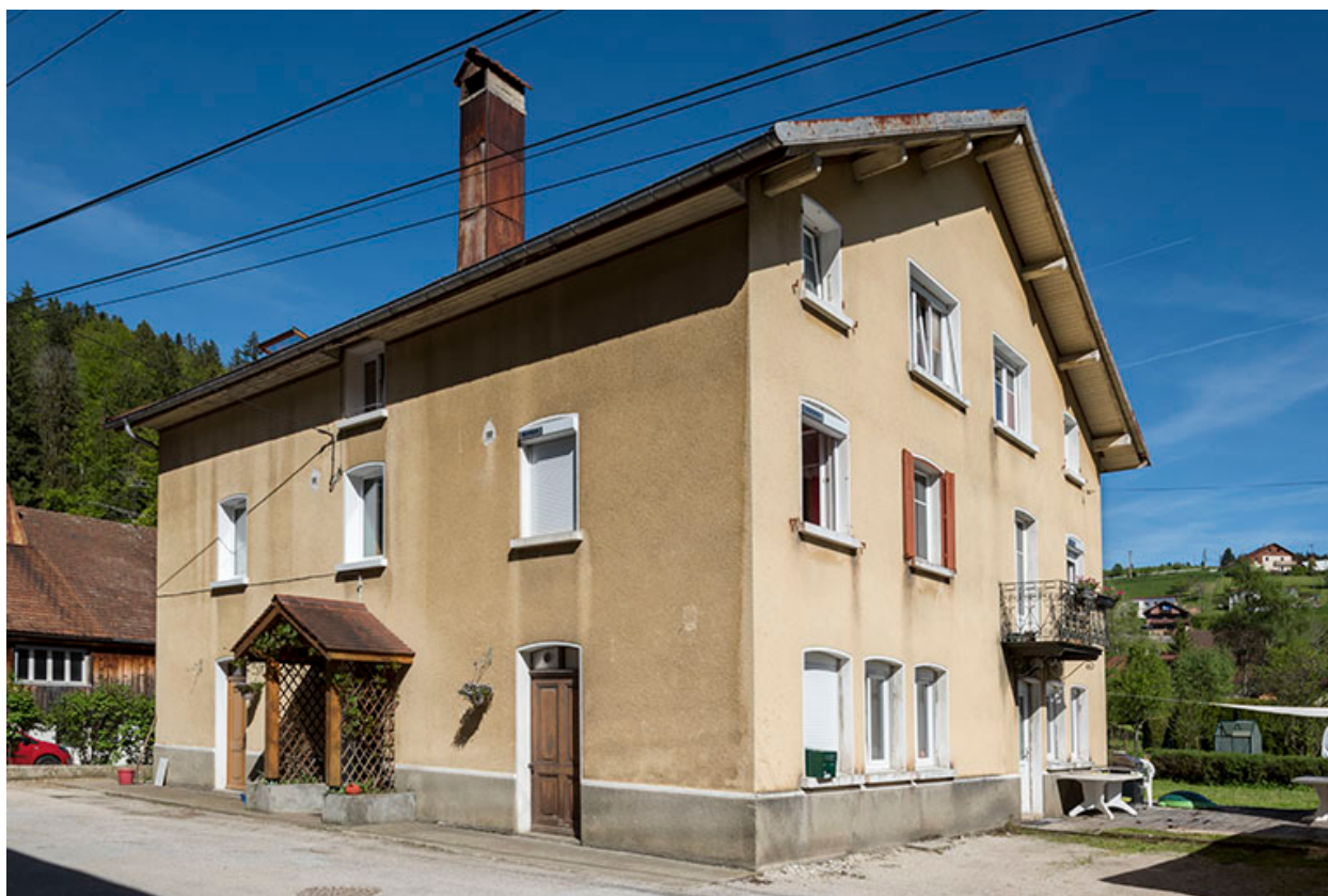
Fonderie : façades antérieure et latérale droite.
