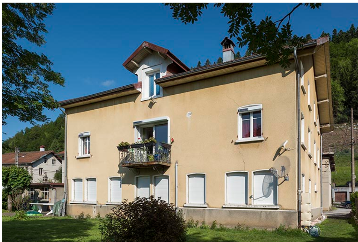
Fonderie : façade postérieure, de trois quarts droite.
