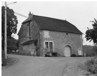
Ferme située route de Frontenay : vue d'ensemble.
