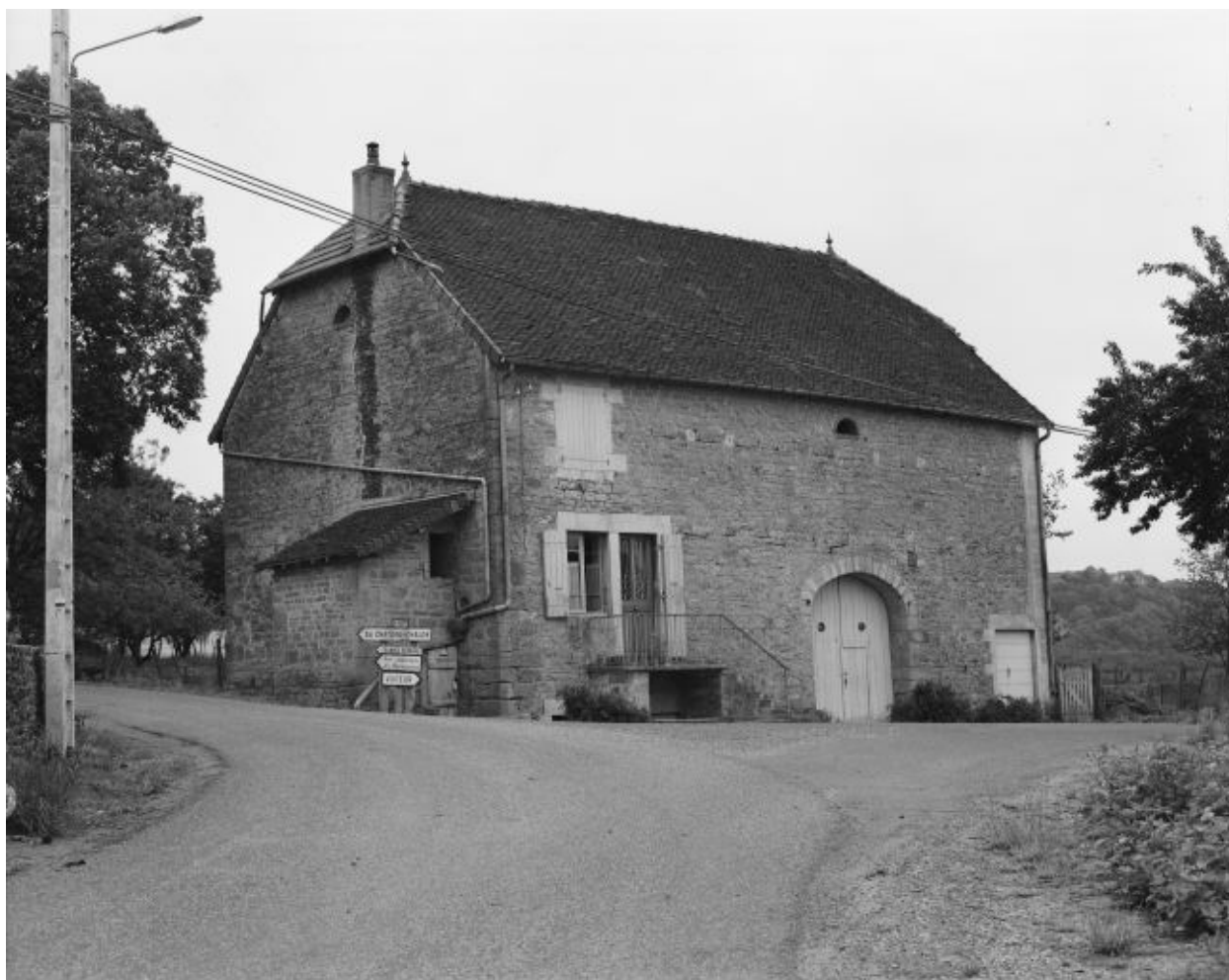
Ferme située route de Frontenay : vue d'ensemble.
