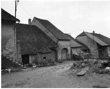
Fermes situées chemin des Vignes : façades sur rue. Phot. Yves Sancey IVR43_19813900189X
