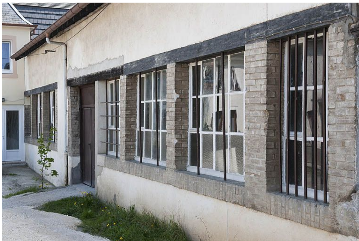
Mur nord de l'atelier de fabrication.
