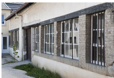
Mur nord de l'atelier de fabrication. Phot. Jérôme Mongreville IVR43_20112501435NUC4A
