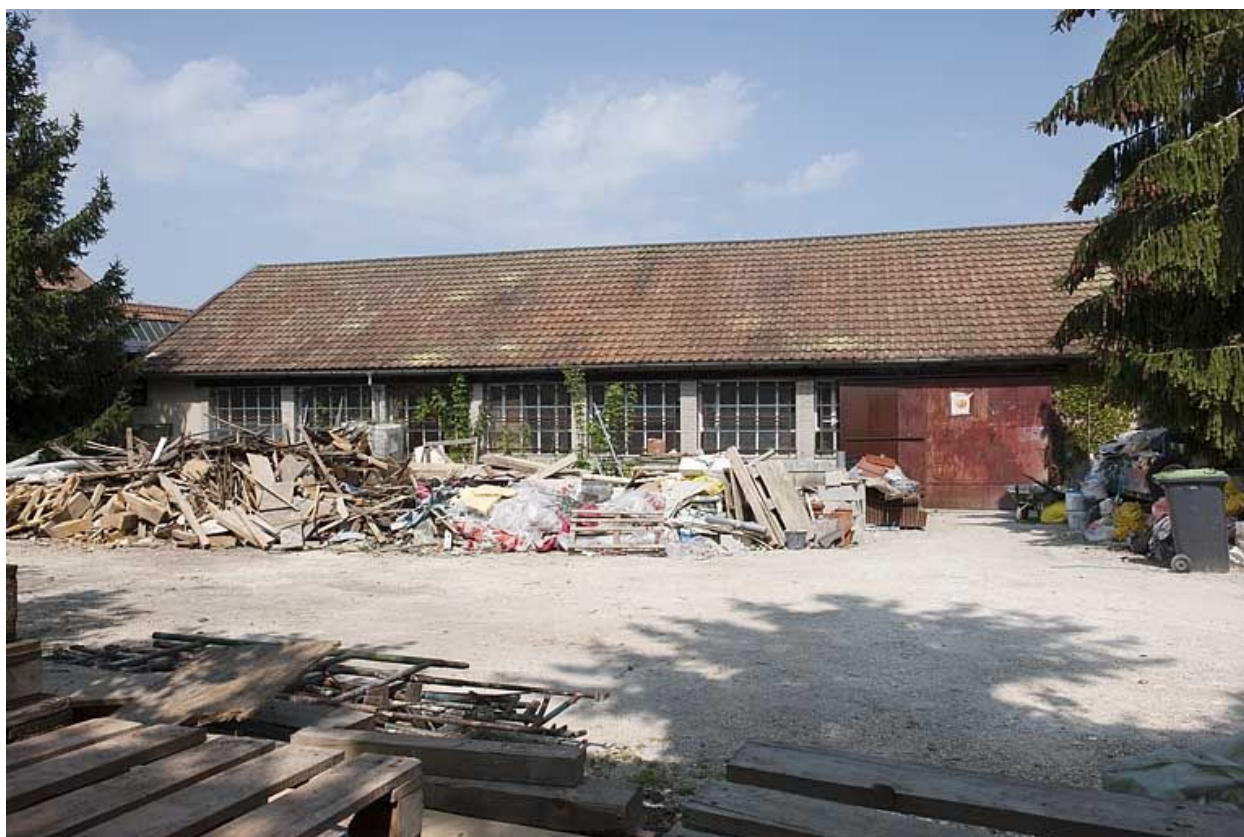
Façade sud de l'atelier de fabrication.
