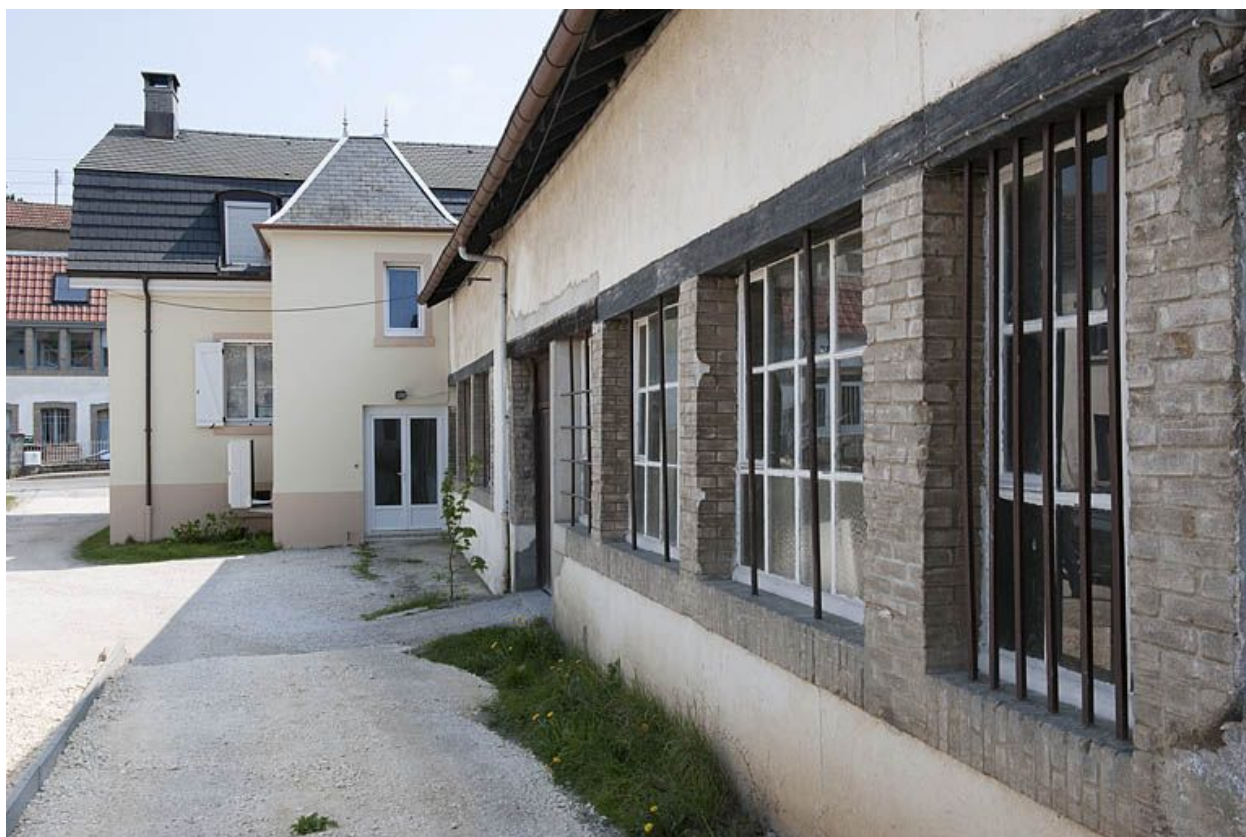
Logement et atelier de fabrication depuis l'ouest.
