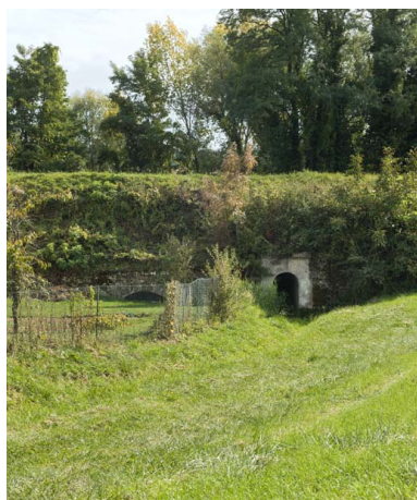
Vue de l'ouvrage.
