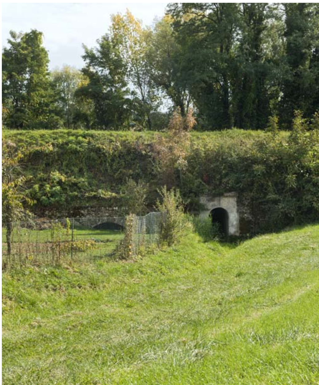
Vue de l'ouvrage.
