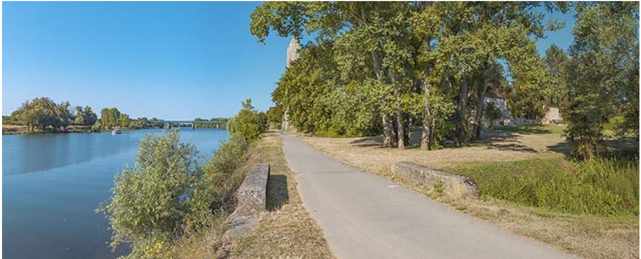
La digue de Chauvort, vue d'amont.
