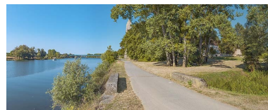
La digue de Chauvort, vue d'amont.
