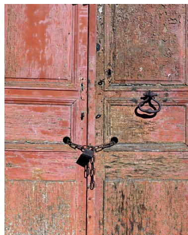
Entrée principale : détail des vantaux. Phot. Yves Sancey IVR43_20033900499XA
