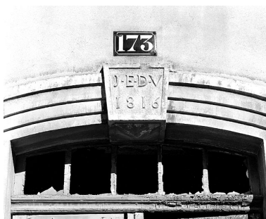
Entrée principale : date et initiales. Phot. Yves Sancey IVR43_20033900497X
