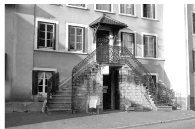
Détail de l'escalier. Phot. Bernard Lardière IVR43_19832500085Z
