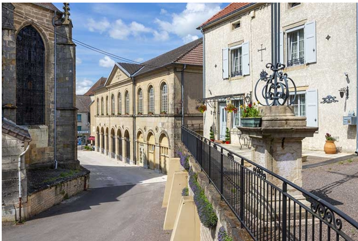
Vue éloignée depuis le sud.
