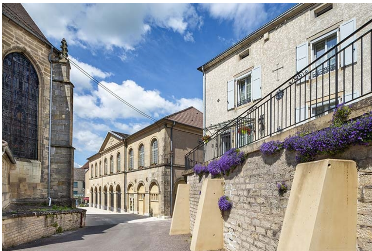
Vue éloignée depuis le sud.
