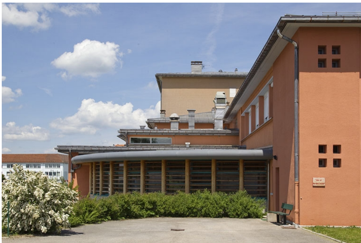
Bâtiment de la restauration : extrémité sud.
