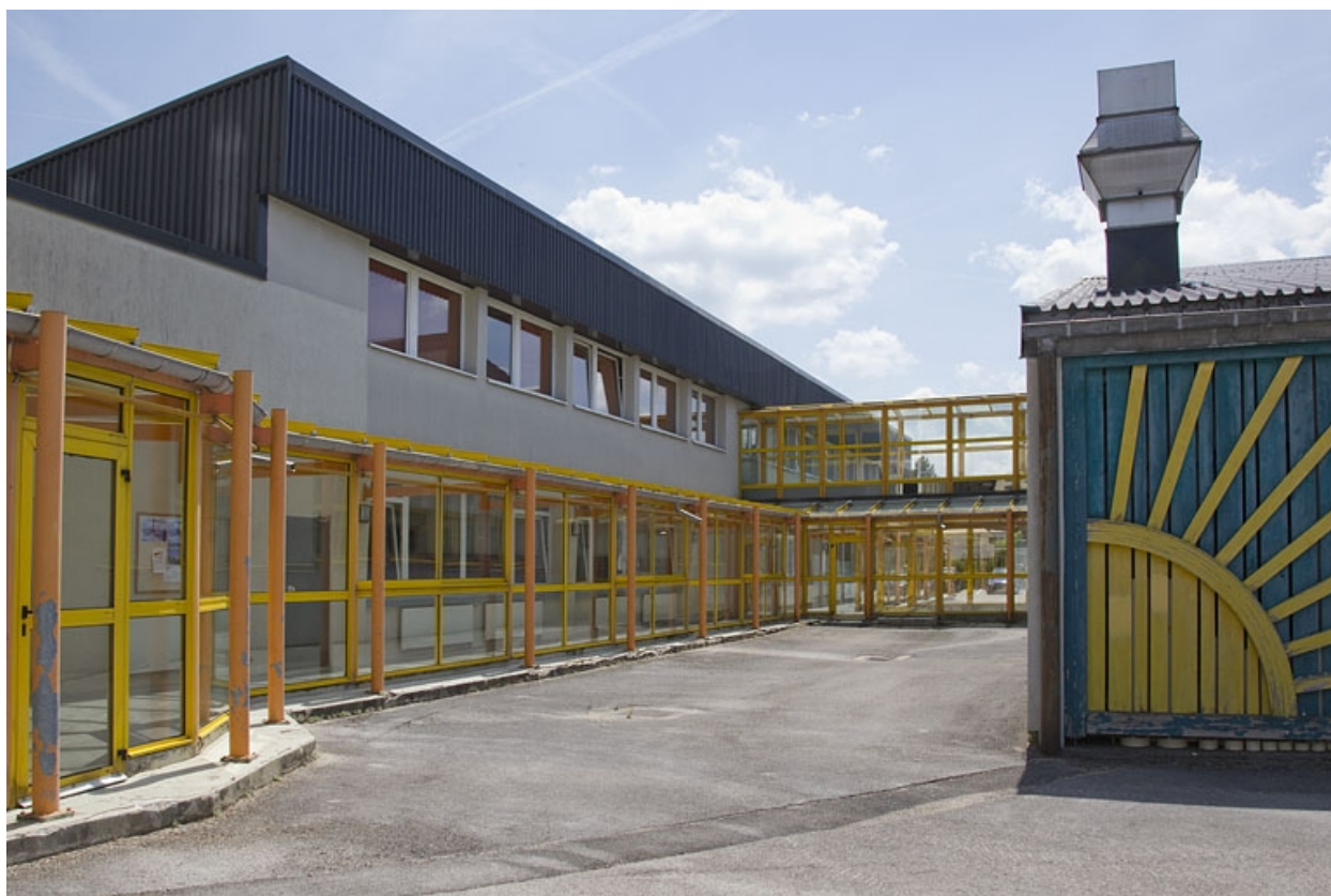
Galerie et atelier de maintenance et électrotechnique.
