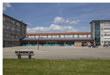
Bâtiment de l'administration : face postérieure. Phot. Yves Sancey IVR43_20122500815NUC2A
