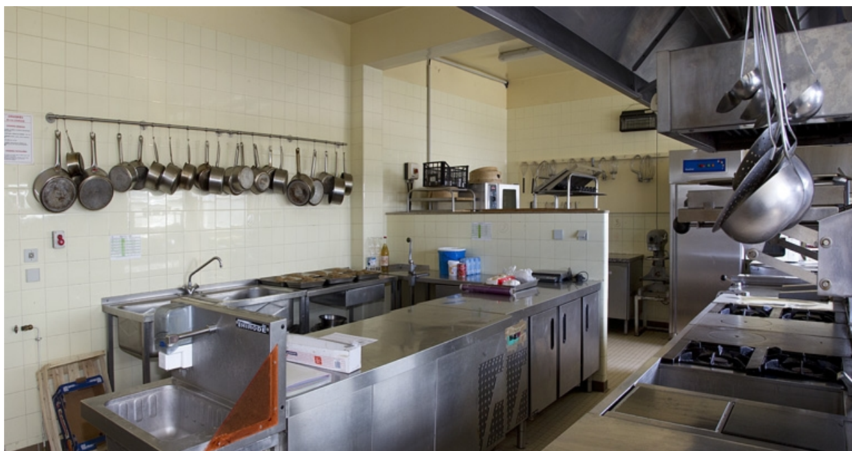
Bâtiment de l'hôtellerie : cuisine pédagogique (nord).
