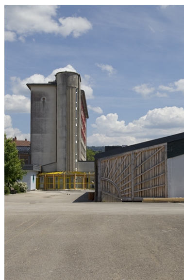
Internat garçons : face latérale et cage d'escalier. Phot. Yves Sancey IVR43_20122500809NUC2A
