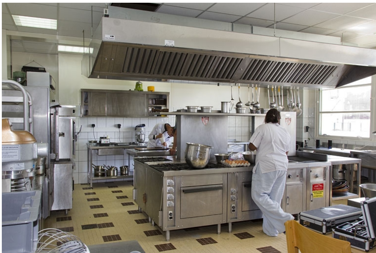
Bâtiment de l'hôtellerie : cuisine pédagogique (sud).
