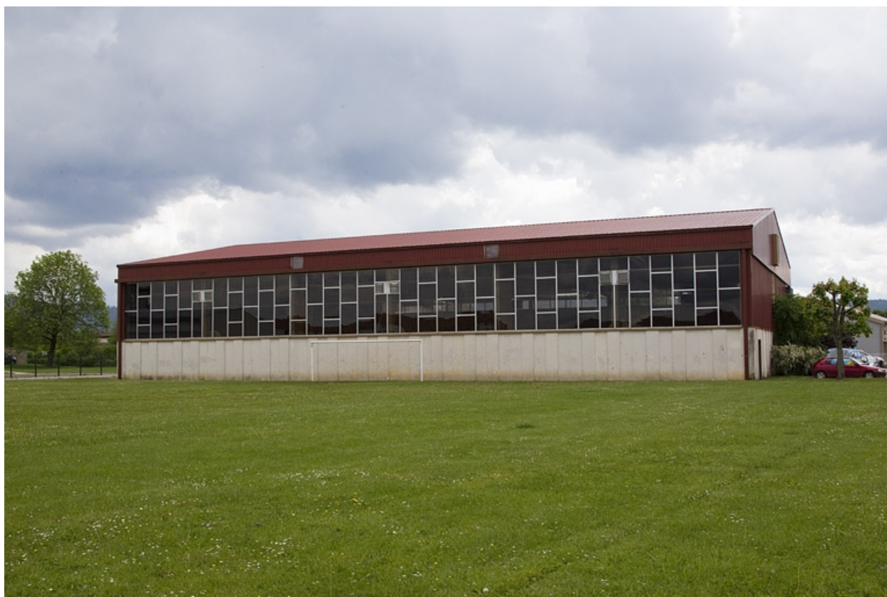
Grand gymnase occidental, vu du nord.
