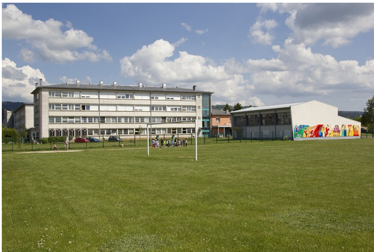
Bâtiment de l'hôtellerie et gymnase.
