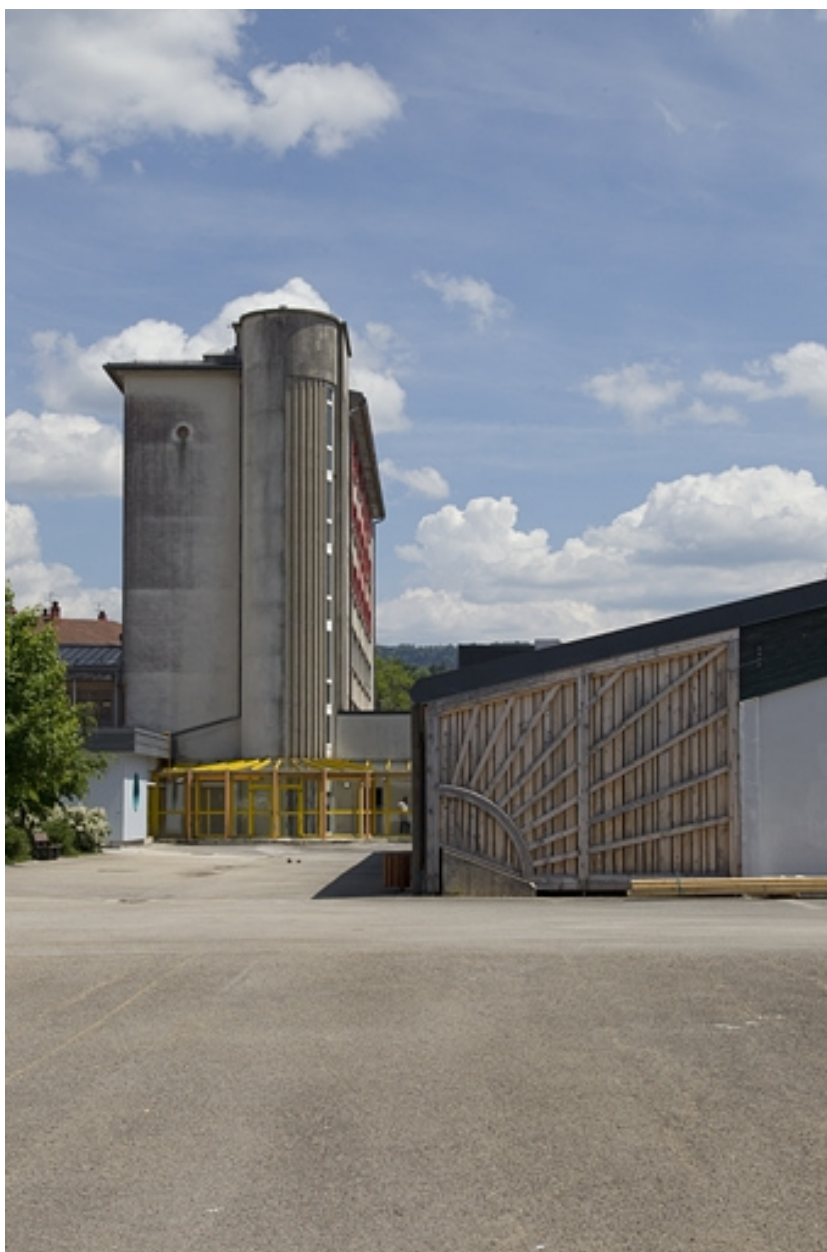
Internat garçons : face latérale et cage d'escalier.
