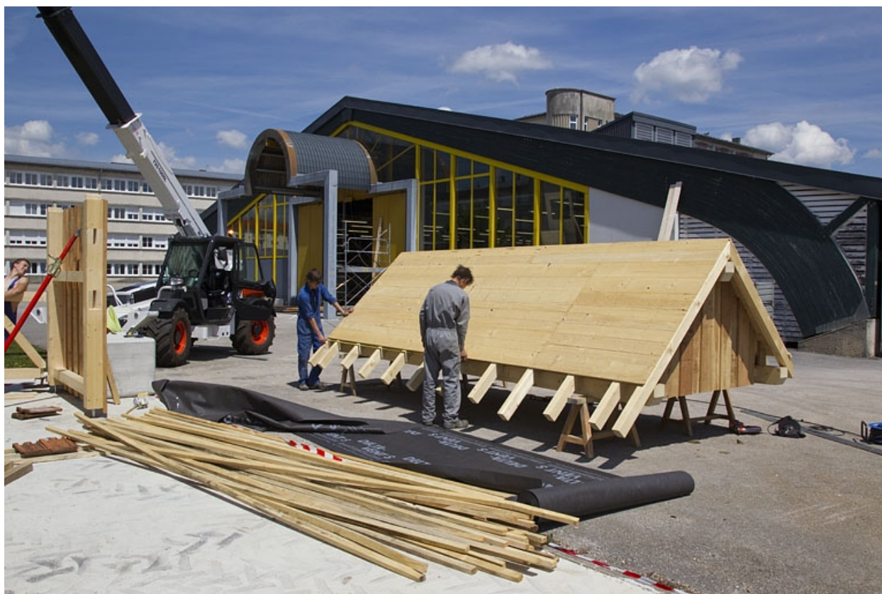
Atelier des métiers du bois et aire de montage : élèves réalisant une toiture.
