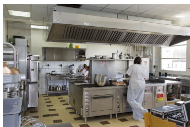
Bâtiment de l'hôtellerie : cuisine pédagogique (sud).
