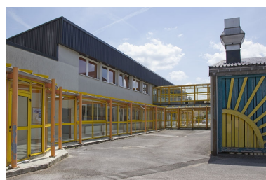
Galerie et atelier de maintenance et électrotechnique.
