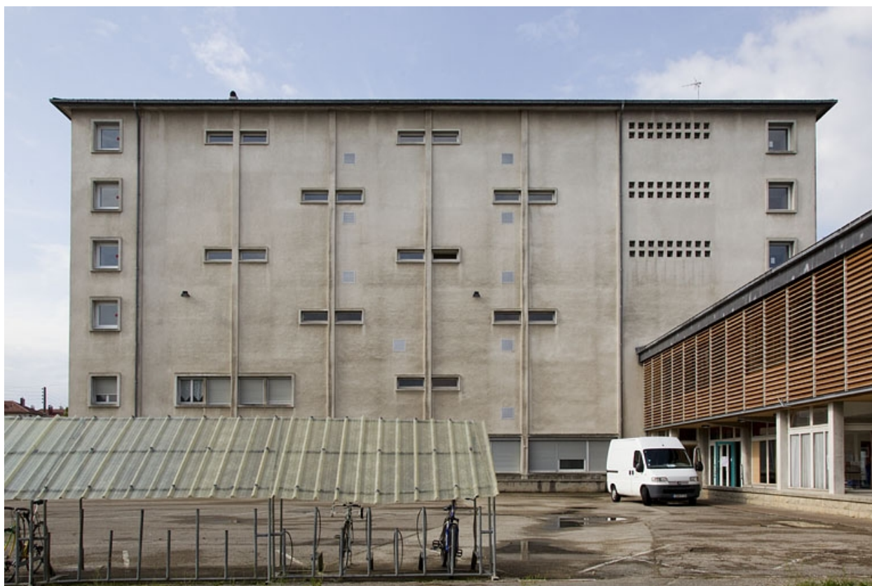
Internat garçons, vu du nord.
