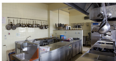
Bâtiment de l'hôtellerie : cuisine pédagogique (nord).
