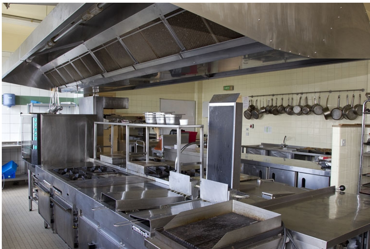
Bâtiment de l'hôtellerie : cuisine pédagogique (nord).
