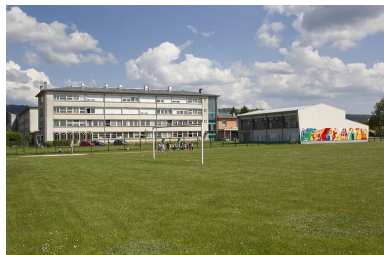
Bâtiment de l'hôtellerie et gymnase.
