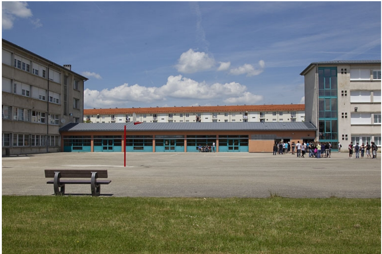
Bâtiment de l'administration : face postérieure.
