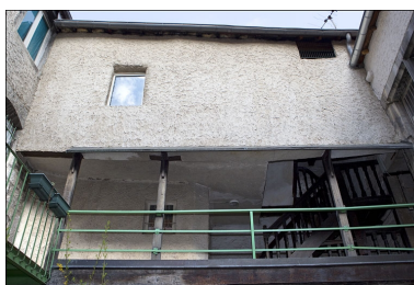
Escalier à cage ouverte : détail de la coursière desservant le premier étage du logis secondaire, face depuis la cour.
