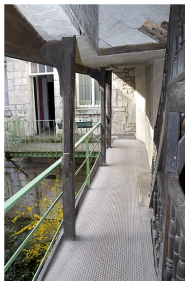
Escalier à cage ouverte : détail de la coursière desservant le premier étage du logis secondaire.
