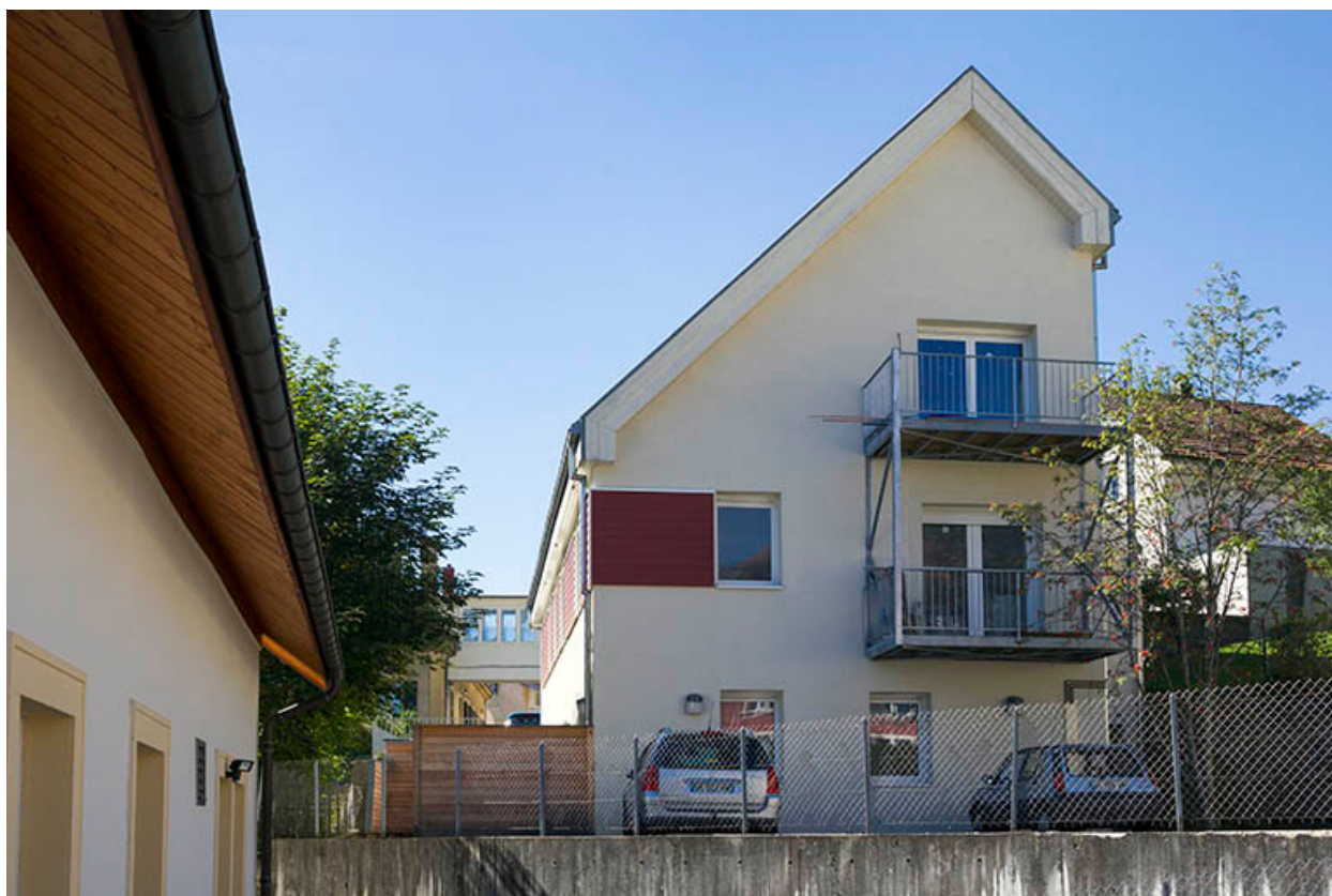
Façade nord du troisième corps de bâtiment.
