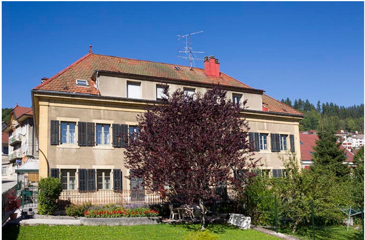
Maison : façade latérale droite.
