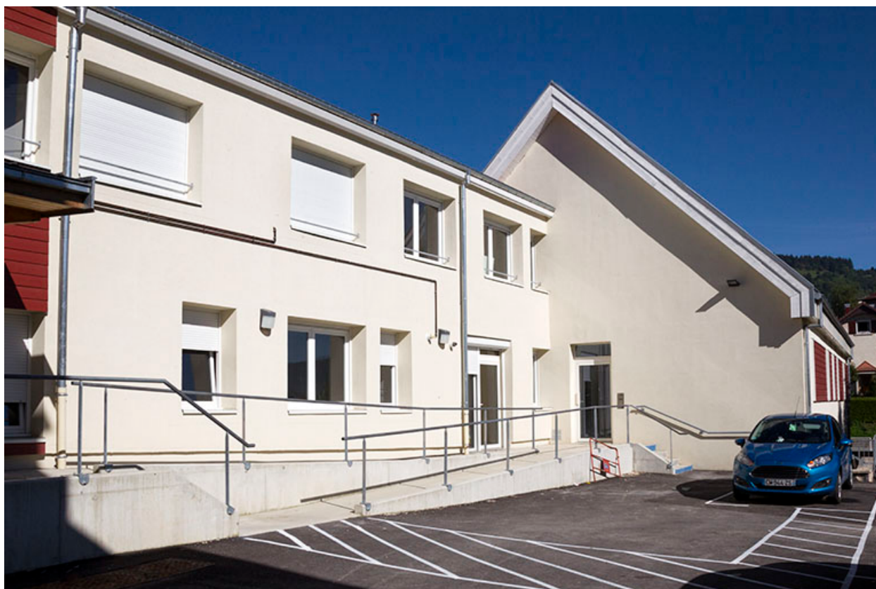
Usine : deuxième et troisième corps de bâtiment.
