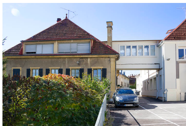
Maison : façade postérieure et passerelle.
