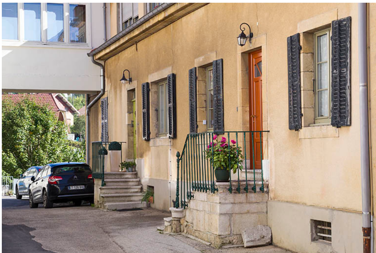
Maison : façade latérale gauche, vue en enfilade.
