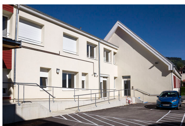
Usine : deuxième et troisième corps de bâtiment.
