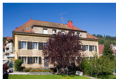
Maison : façade latérale droite.
