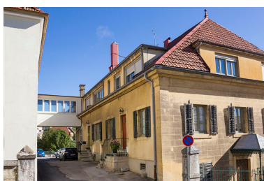
Maison : façade latérale gauche et passerelle.
