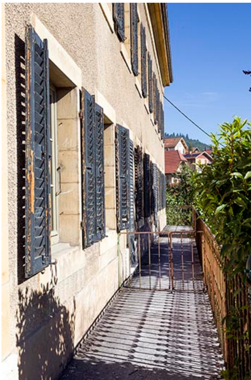
Maison : façade latérale droite, vue en enfilade.
