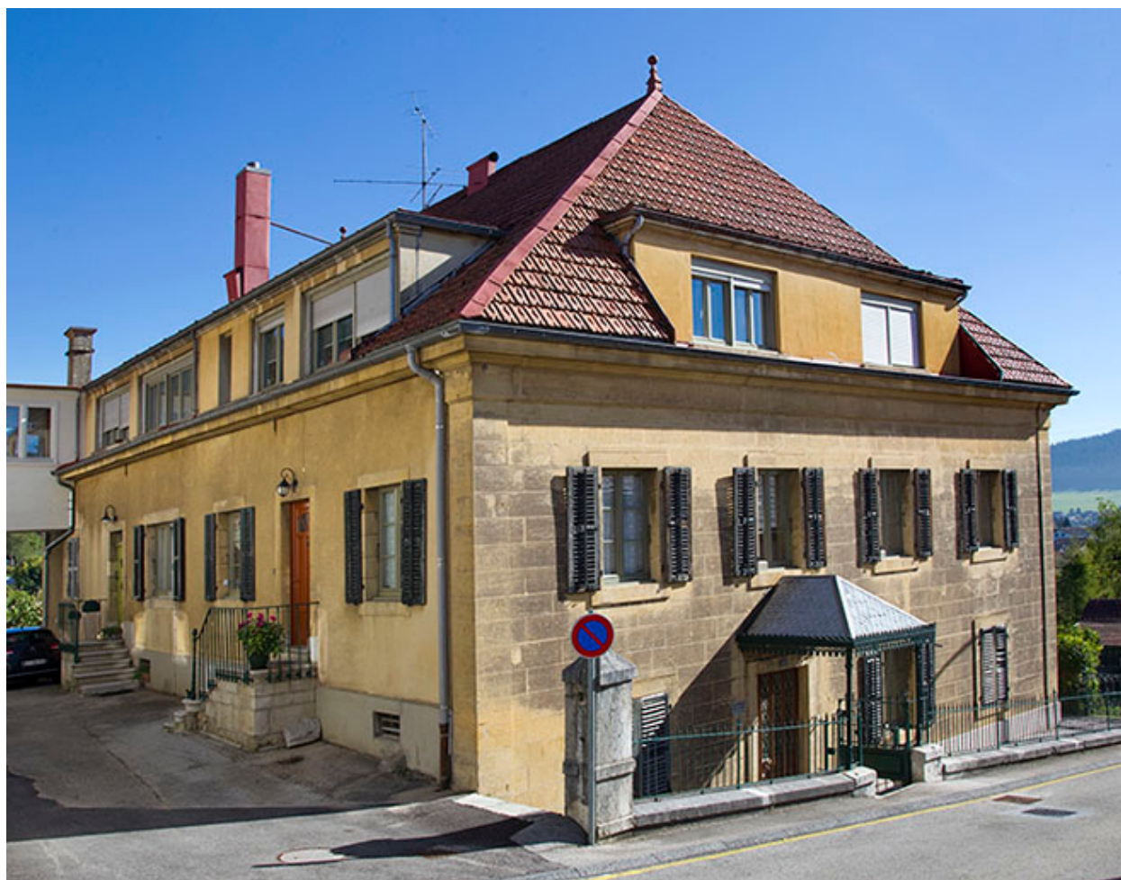
Maison : façades antérieure et latérale gauche.
