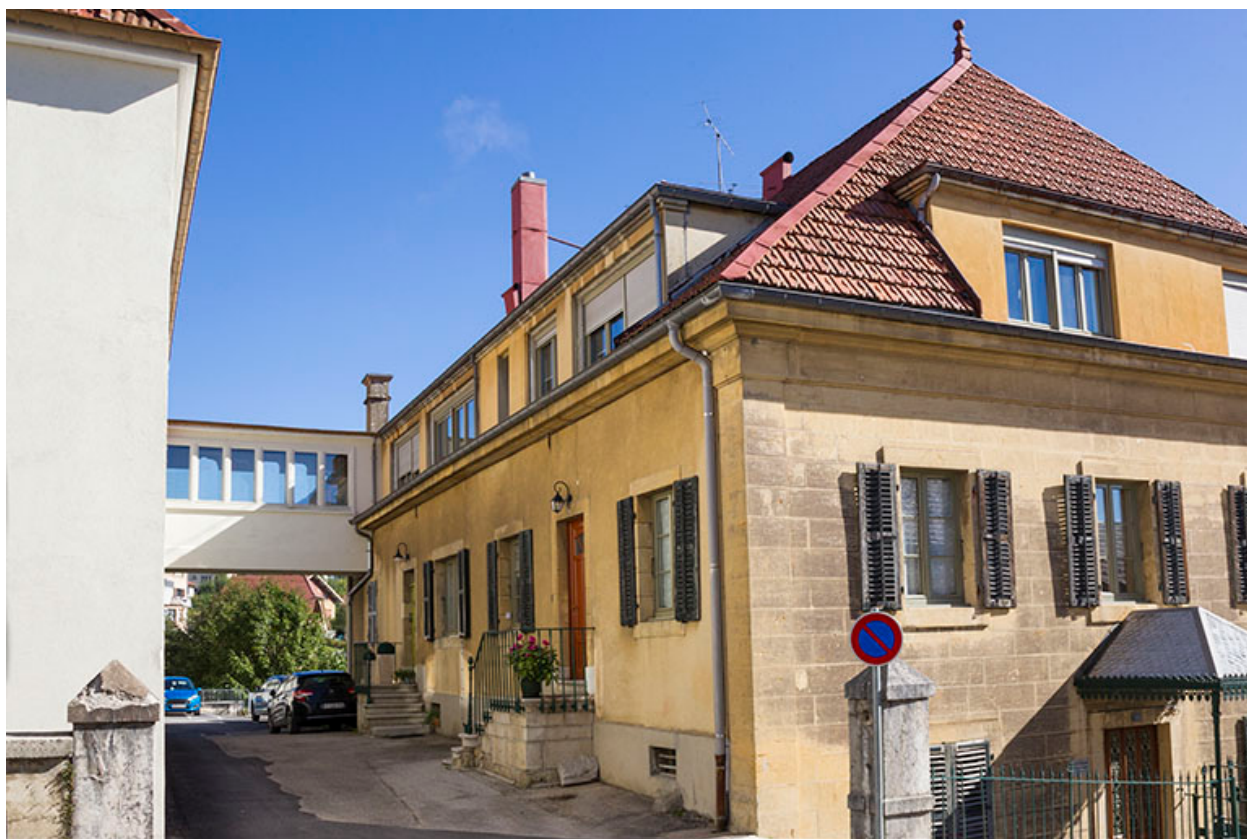
Maison : façade latérale gauche et passerelle.
