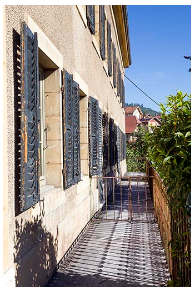
Maison : façade latérale droite, vue en enfilade.
