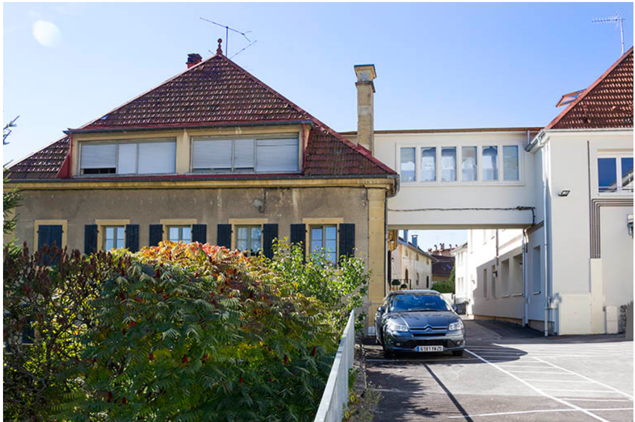
Maison : façade postérieure et passerelle.
