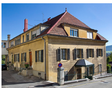
Maison : façades antérieure et latérale gauche.
