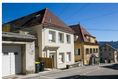
Vue d'ensemble, depuis l'ouest.
