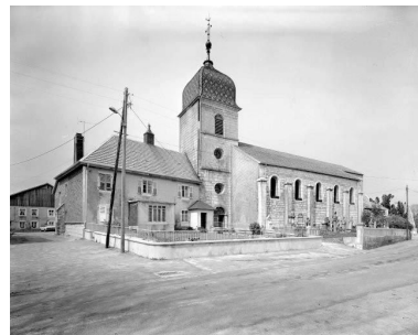
Vue de trois quarts avant droit. Phot. Yves Sancey IVR43_19782500107V
