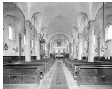
Nef et chœur. Phot. Yves Sancey IVR43_19782500108V
